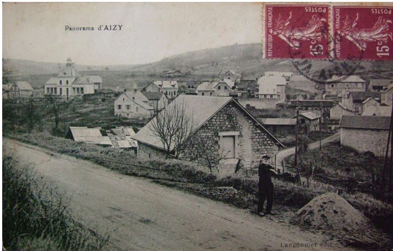
Vue du village en reconstruction (coll. part).
