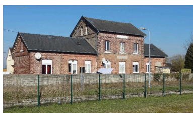
Vue générale de la façade sur voie. Phot. Romain Grimaud IVR22_20128015511NUCA
