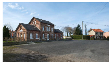
Vue générale depuis la place de la gare. Phot. Thierry Lefébure IVR22_20138000120NUC2AQ
