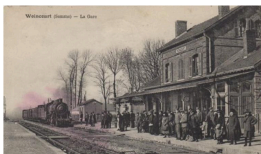
Vue du quai de la gare, début du 20e siècle (coll. part.). Phot. Frédéric-Nicolas Kocourek (reproduction) IVR22_20158006524NUCA
