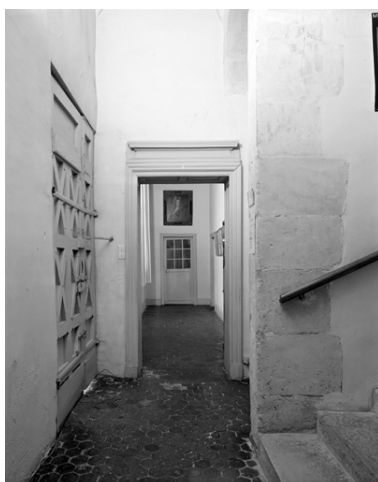
Corridor d'entrée et couloir du rez-de-chaussée. Phot. Thierry Lefébure IVR22_19930201819V
