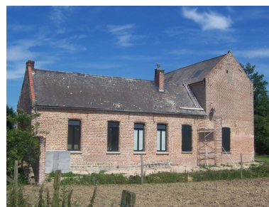
Vue générale postérieure. Phot. Cyril Cailleau IVR31_20055907323NUCA
