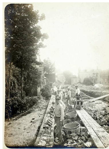
Chantier de construction de l'École primaire supérieure : ouvriers sur le chantier. (AD Pas-de-Calais, 20612/2). Phot. Thibaut Pierre (reproduction) IVR32_20216200242NUCA
