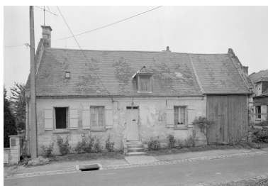
Logis. Elévation antérieure. Phot. Jean-Michel Perrin IVR22_19846001004X
