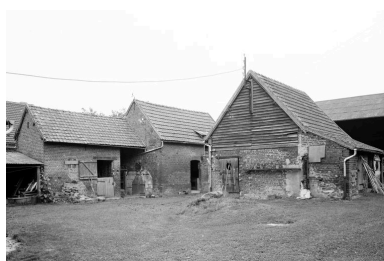
Bâtiments d'exploitation. Phot. Jean-Michel Perrin IVR22_19846000996X
