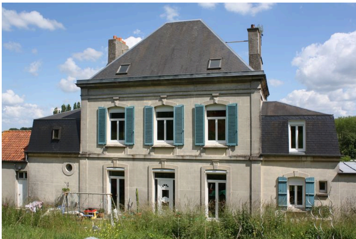
Elévation postérieure, sur jardin.
