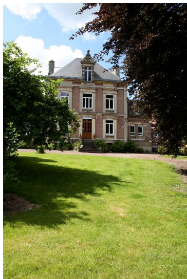
Vue d'ensemble. Phot. Bertrand Fournier IVR22_20088015438NUCA
