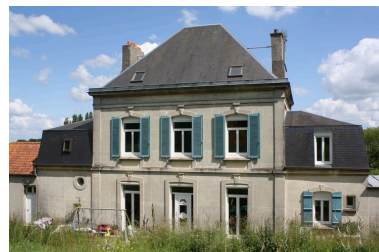
Élévation postérieure, sur jardin. Phot. Bertrand Fournier IVR22_20088015440NUCA
