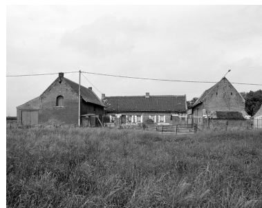
Vue générale, de face. Phot. Philippe Dapvril IVR31_20045900472X
