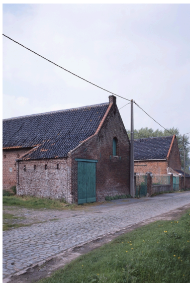
Vue générale. Phot. Pierre Thibaut IVR31_20095902067XA
