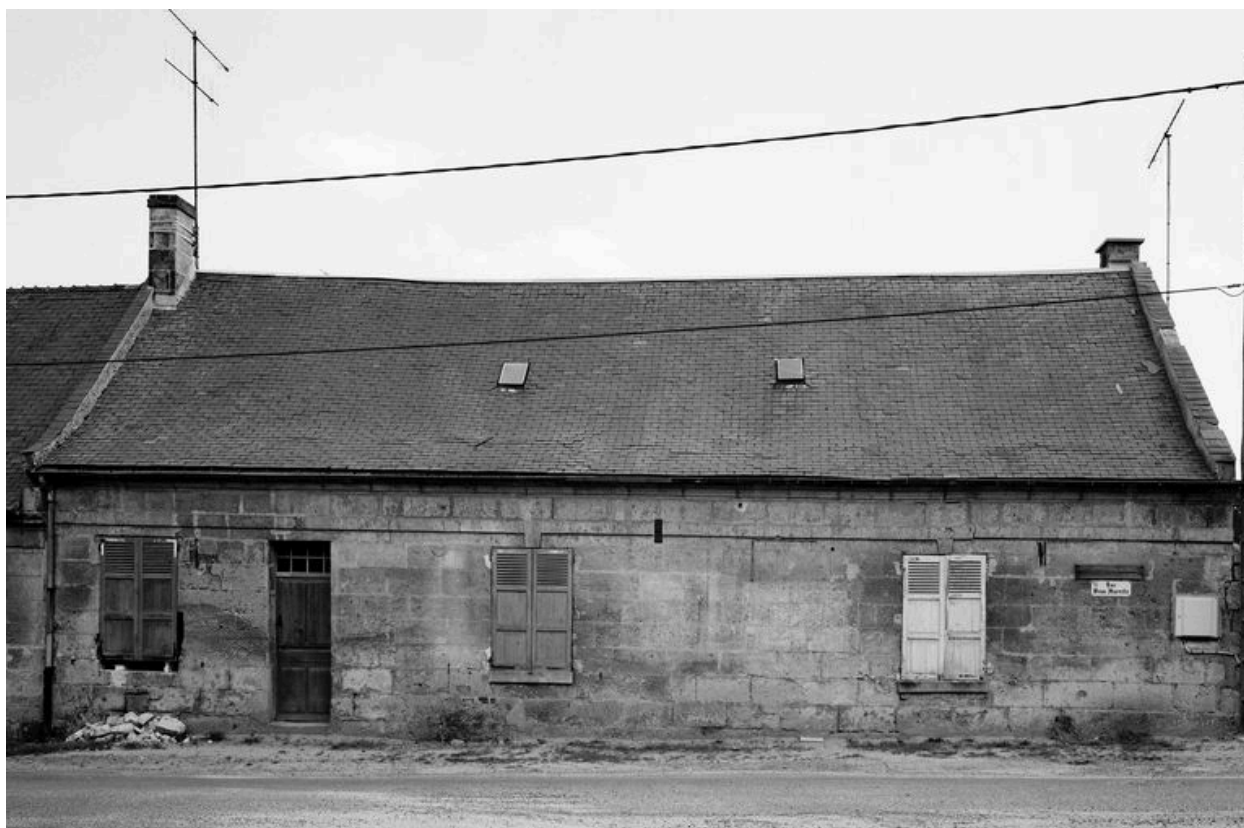
Logis. Elévation sur rue.
