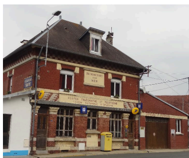
Vue de trois-quarts depuis la Place Publique. Phot. Frédéric-Nicolas Kocourek IVR22_20158005022NUCA
