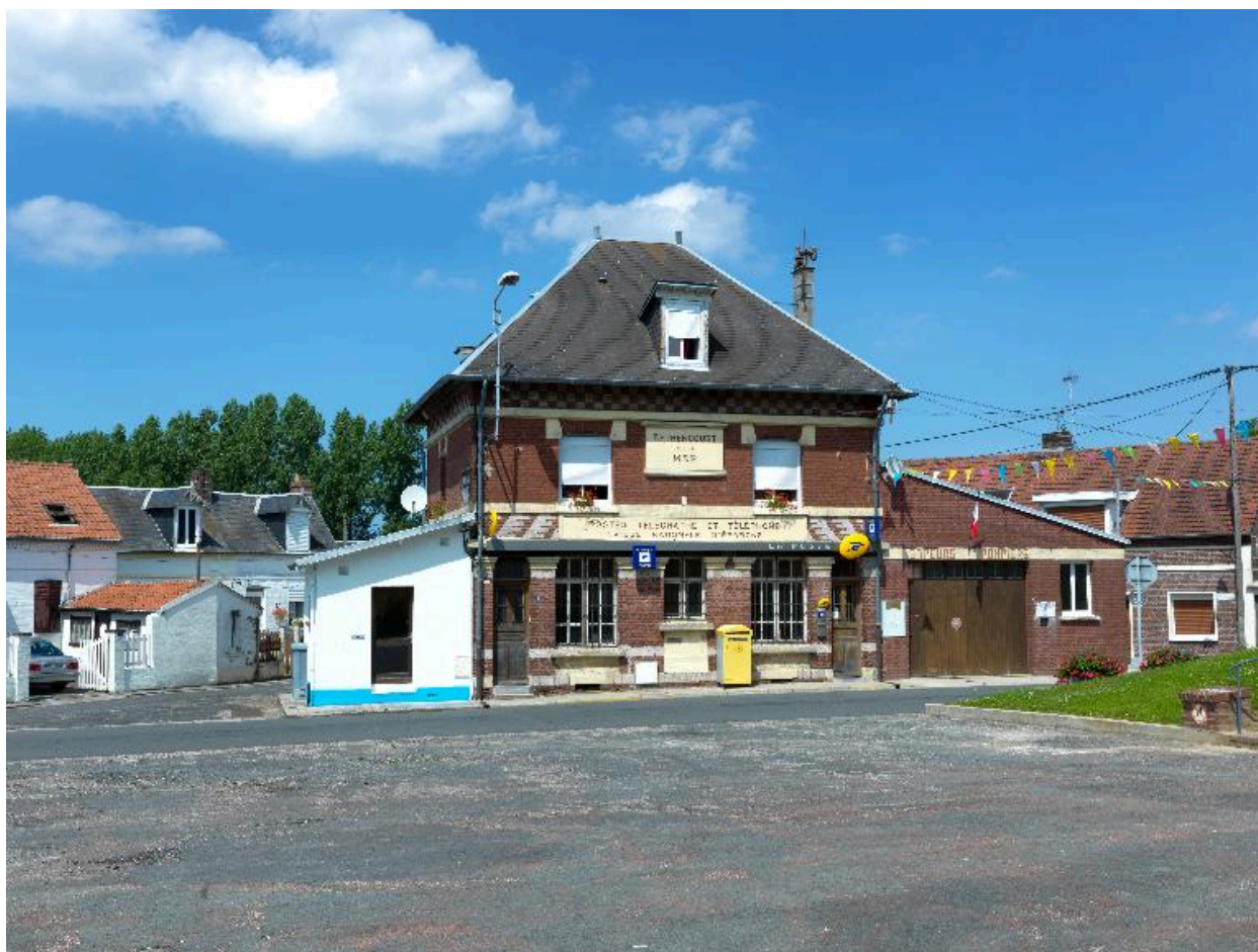
Vue générale depuis la place de l'Eglise.
