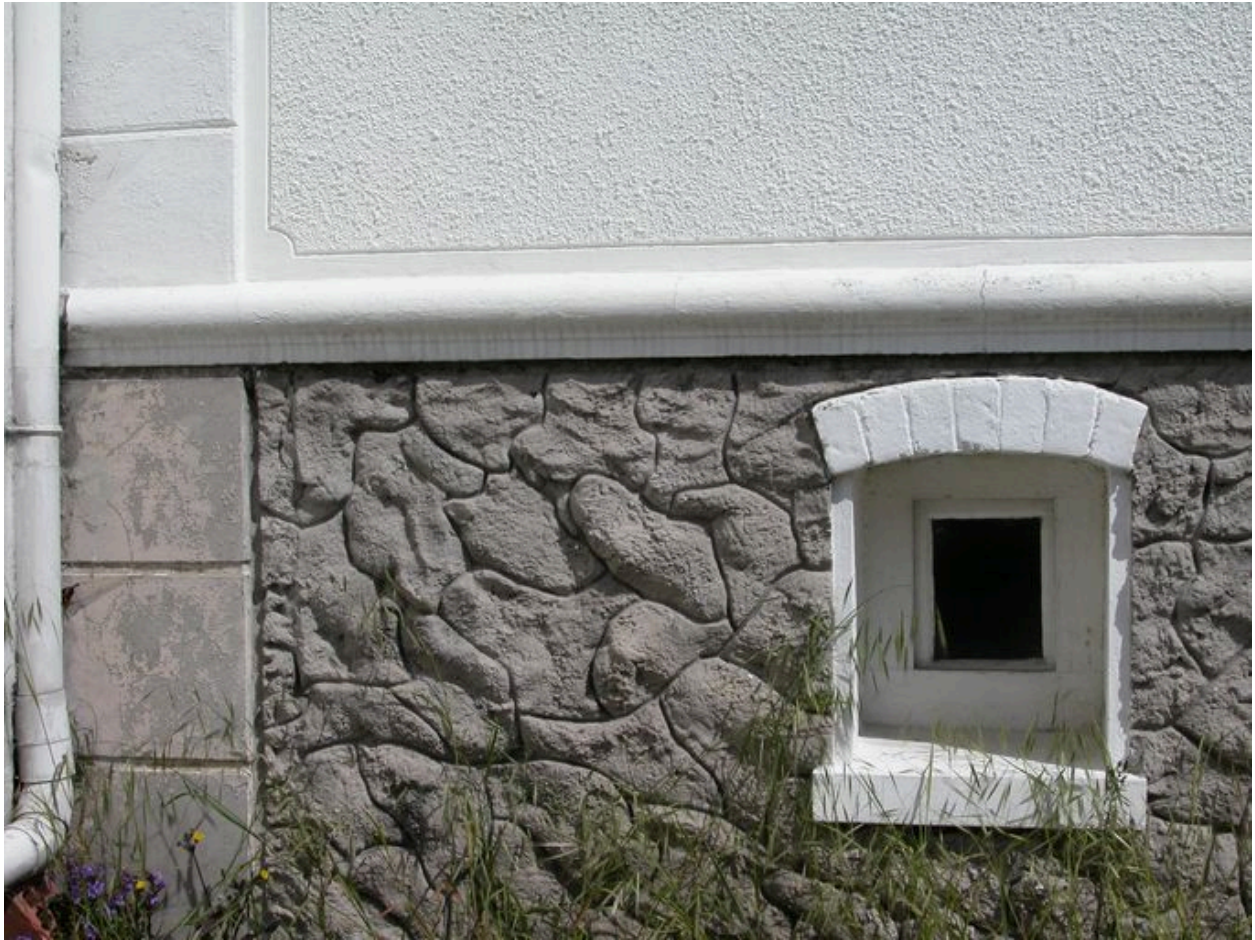
Détail du traitement de la base du mur, en enduit imitant des moellons de pierres.
