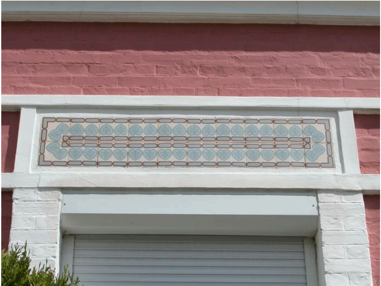
Détail d'une frise de céramique située au-dessus d'une baie.
