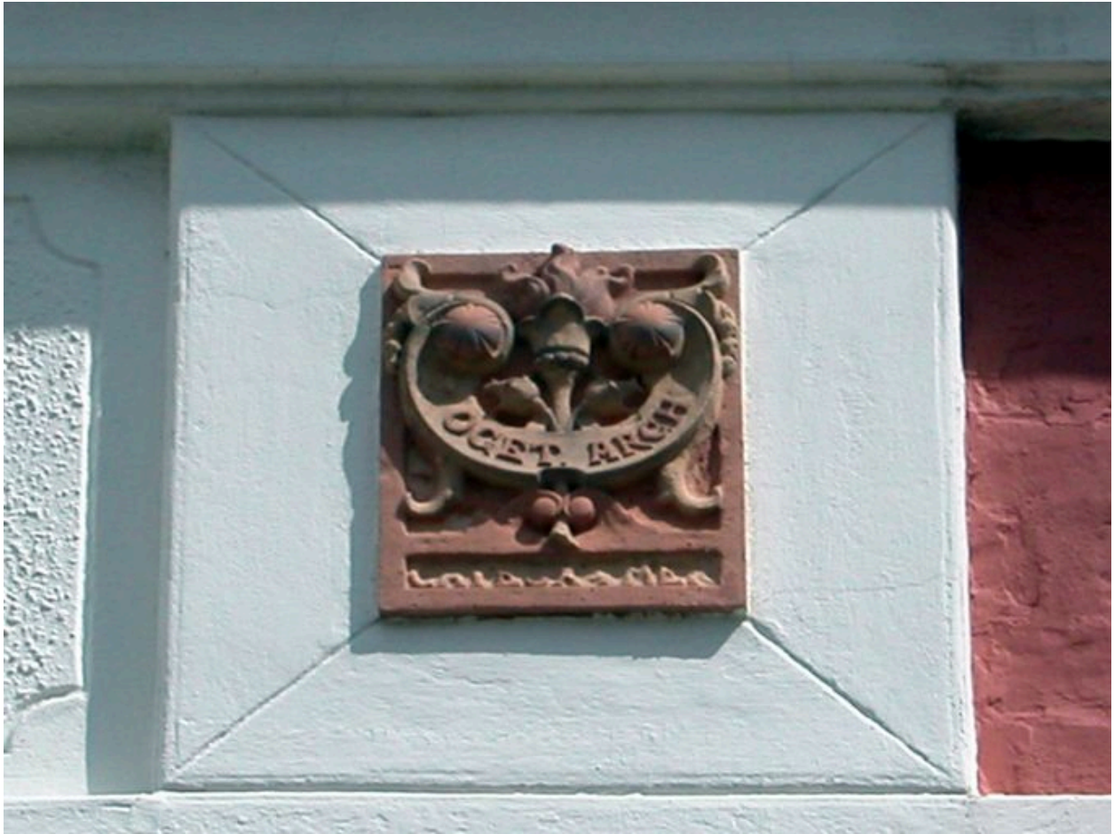
Détail du carreau d'argile portant signature de l'architecte Oget.
