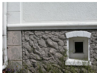
Détail du traitement de la base du mur, en enduit imitant des moellons de pierres. Phot. Elisabeth Justome IVR22_20058002848NUCA
