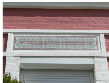
Détail d'une frise de céramique située au-dessus d'une baie. Phot. Elisabeth Justome IVR22_20058002845NUCA
