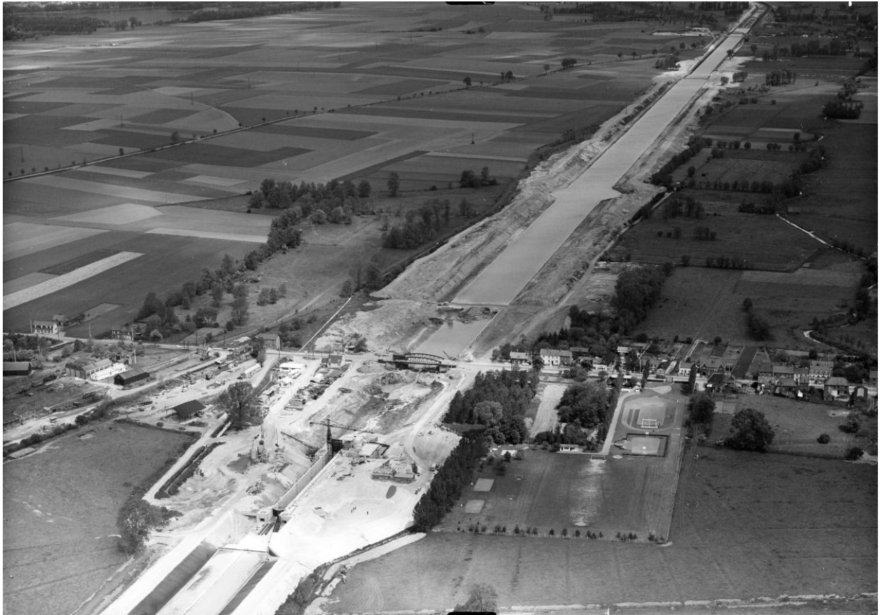
Chantier de construction du canal du Nord. Vue aérienne du port de Marquion lors de la seconde phase de chantier en 1965. (IGN. Photothèque Nationale).
