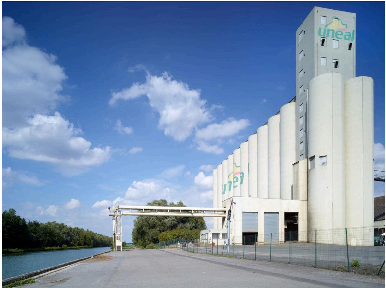
Quai de chargement et unités de stockage de céréales en silos de la rive est (coopérative UNÉAL). Vue depuis le sud.
