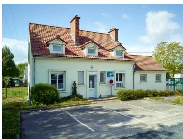
Unité de gestion administrative sectorielle (Voies Navigables de France). À proximité ouest du canal et du pont routier. Phot. Pierre Thibaut IVR32_20216200782NUCA
