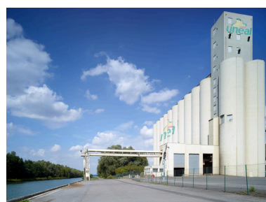
Quai de chargement et unités de stockage de céréales en silos de la rive est (coopérative UNÉAL). Vue depuis le sud. Phot. Pierre Thibaut IVR32_20216200656NUCA
