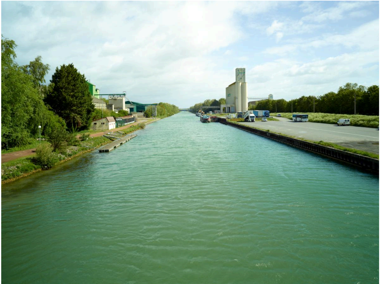
Vue générale du port prise depuis le pont routier de la D939.
