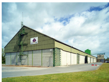
Entrepôt du Groupe Carré sur la rive ouest. Vue depuis le sud du site. Phot. Pierre Thibaut IVR32_20216200661NUCA
