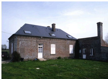
Vue postérieure de la maison. Phot. Irwin Leullier IVR22_20068000148XA
