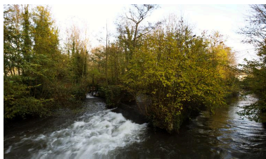
Dérivations et bras de rivière occupés par l'usine. Phot. Thierry Lefébure IVR22_20138000510NUC2AQ
