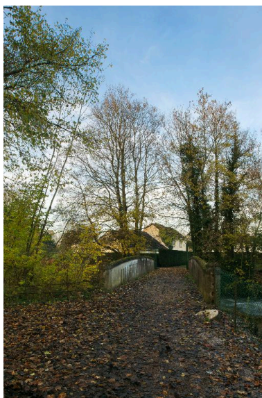
Pont reliant les deux parties de l'ancienne usine. Phot. Thierry Lefébure IVR22_20138000509NUC2A
