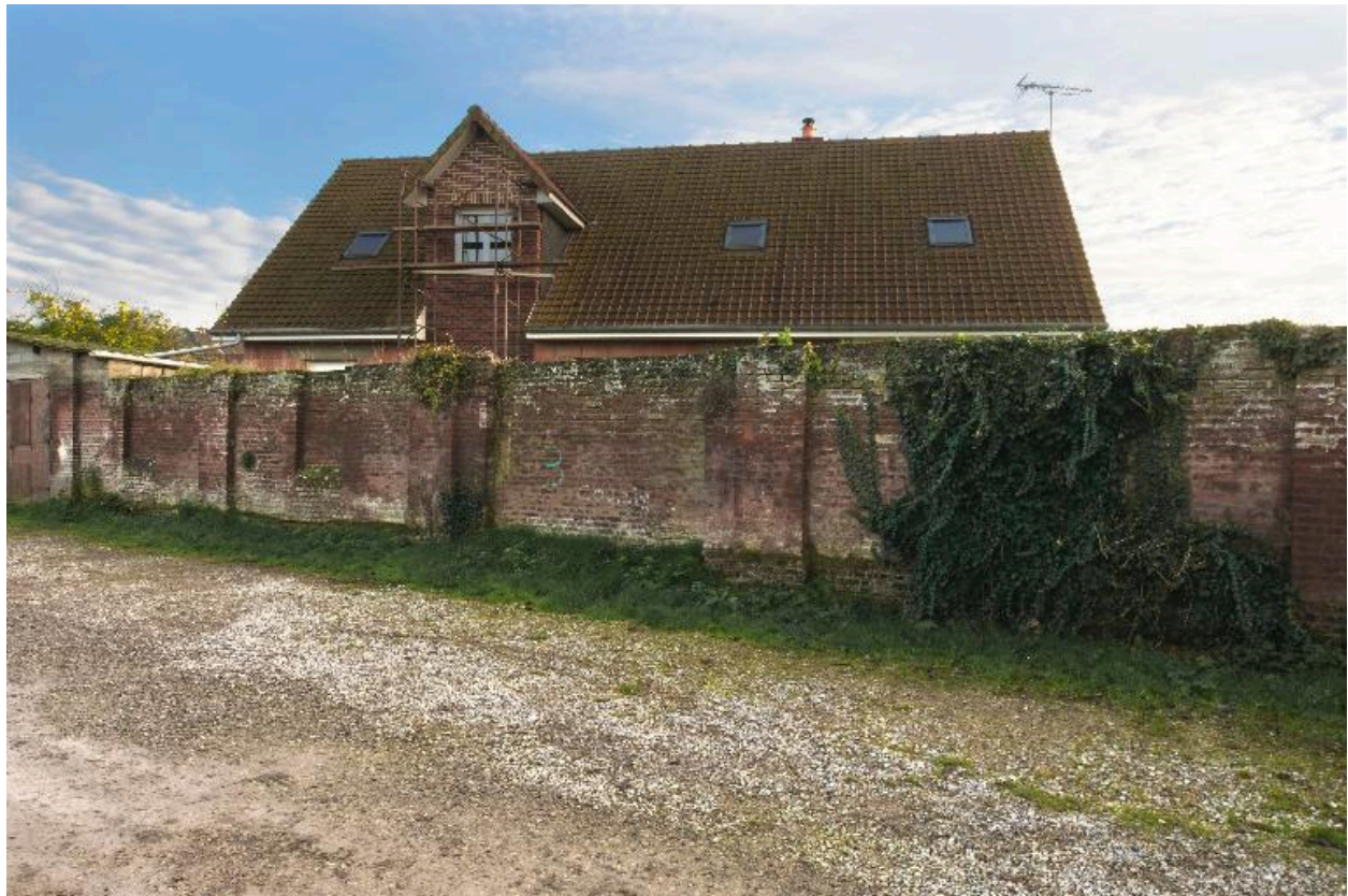
Vestiges des anciens ateliers de tissage, vues depuis le chemin de halage.
