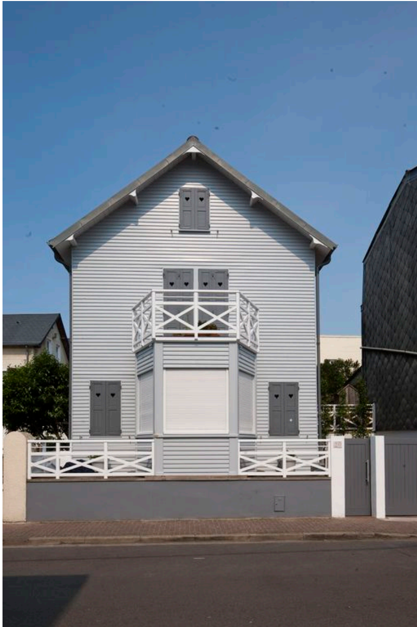
Vue générale de face du chalet en 2013.
