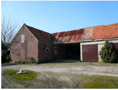
Vue des étables longeant la rue depuis la cour. Phot. Inès Guérin IVR22_20078005529NUCA
