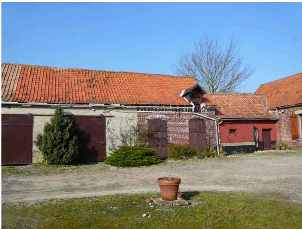
Vue des écuries perpendiculaires au logis.
