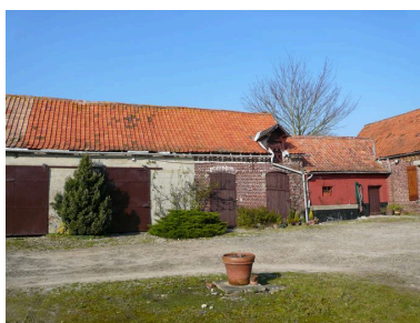
Vue des écuries perpendiculaires au logis.
