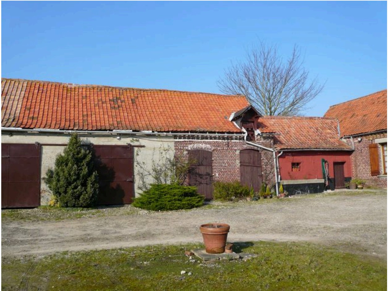
Vue des écuries perpendiculaires au logis.
