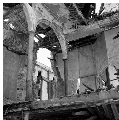
Bâtiment F, salle des fêtes, vue intérieure vers dégagement. Phot. Jean-Michel Périn, Phot. Éric Dessert IVR31_19806202679X
