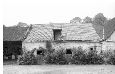
Elévation sur cour de l'étable à chevaux. Phot. Thierry Lefébure IVR22_19920201078Z
