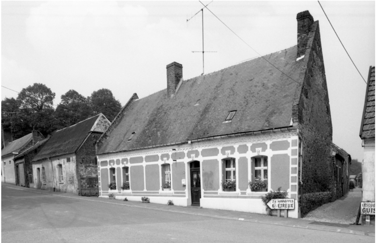
Vue d'ensemble du logis, depuis le sud.
