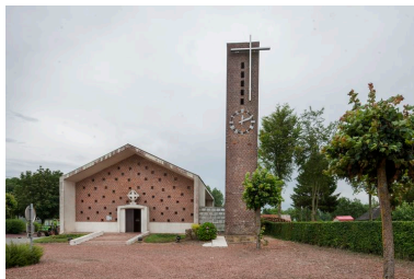
Vue de la façade. Phot. Hubert Bouvet IVR31_20156200128NUCA
