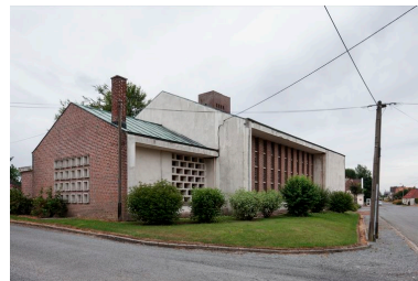
Vue de trois quart arrière. Phot. Hubert Bouvet IVR31_20156200129NUCA
