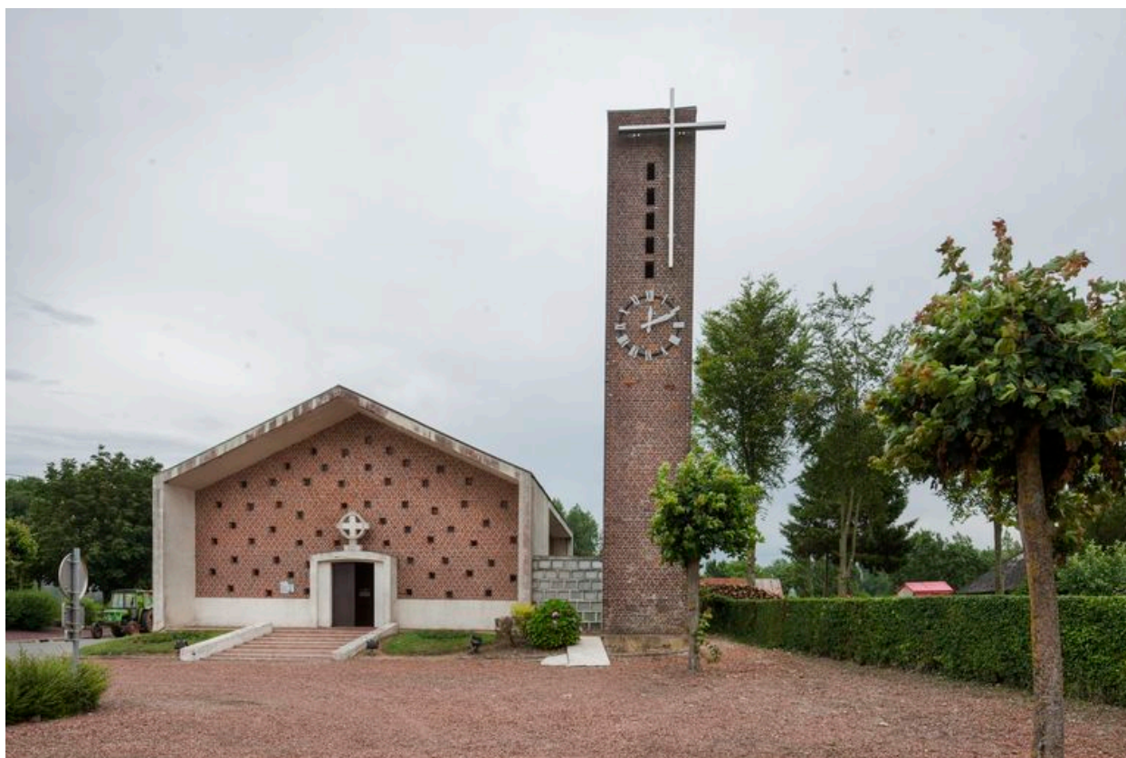
Vue de la façade.
