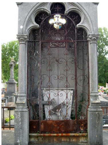
Vue de la grille. Phot. Isabelle Barbedor IVR22_20078010294NUCA
