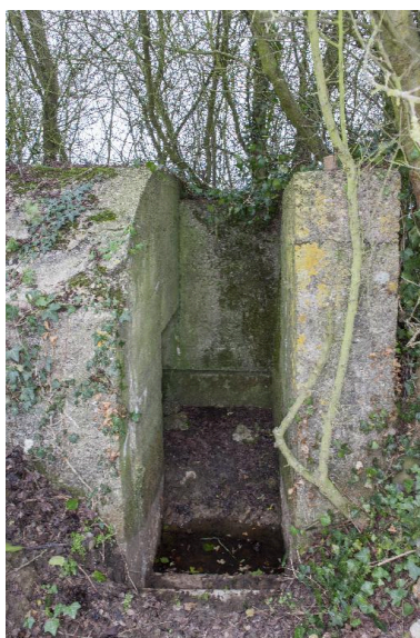
L'escalier latéral et l'entrée sont protégés par un mur pare-souffle Phot. Pierre Thibaut IVR31_20155902006NUCA
