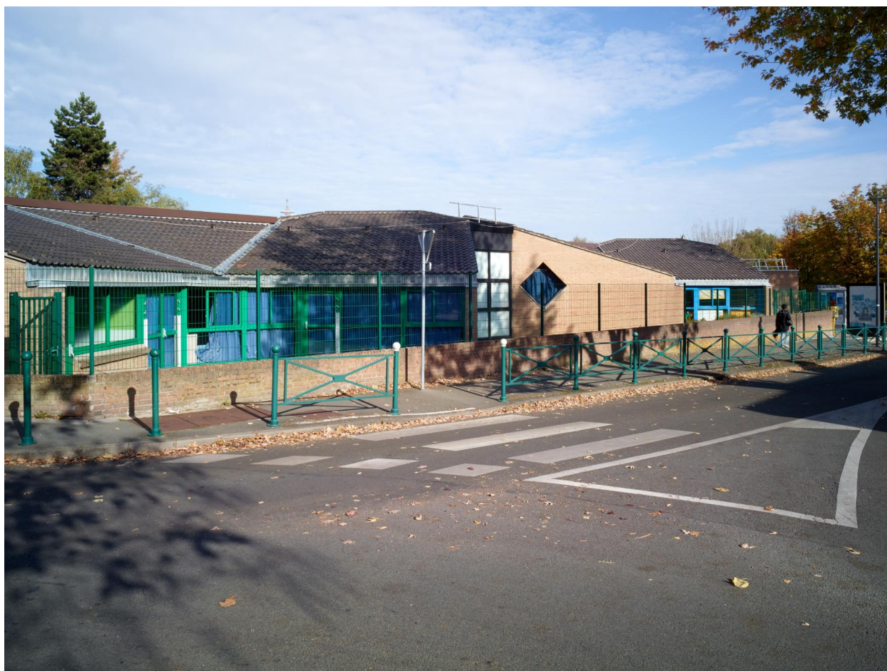
La façade sur rue de la maternelle : deux modules de classes assemblés autour d'un atelier (vue vers le nord).
