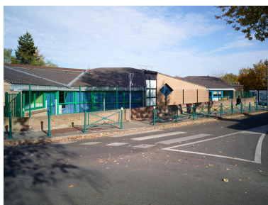
La façade sur rue de la maternelle : deux modules de classes assemblés autour d'un atelier (vue vers le nord).
