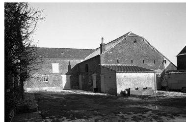
La cour et les étables. Phot. Thierry Lefébure IVR22_19960200990X
