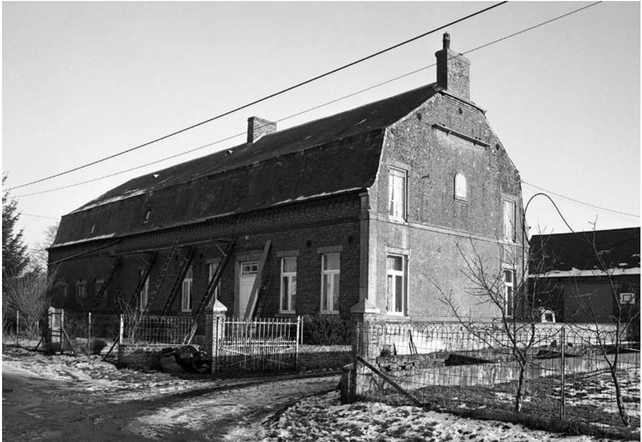
Le logis. Façade postérieure.
