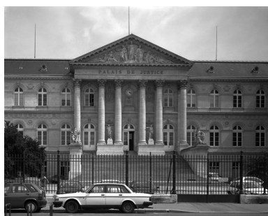
Détail sur le portique de la façade occidentale. Phot. Thierry Lefébure IVR22_19988000420V
