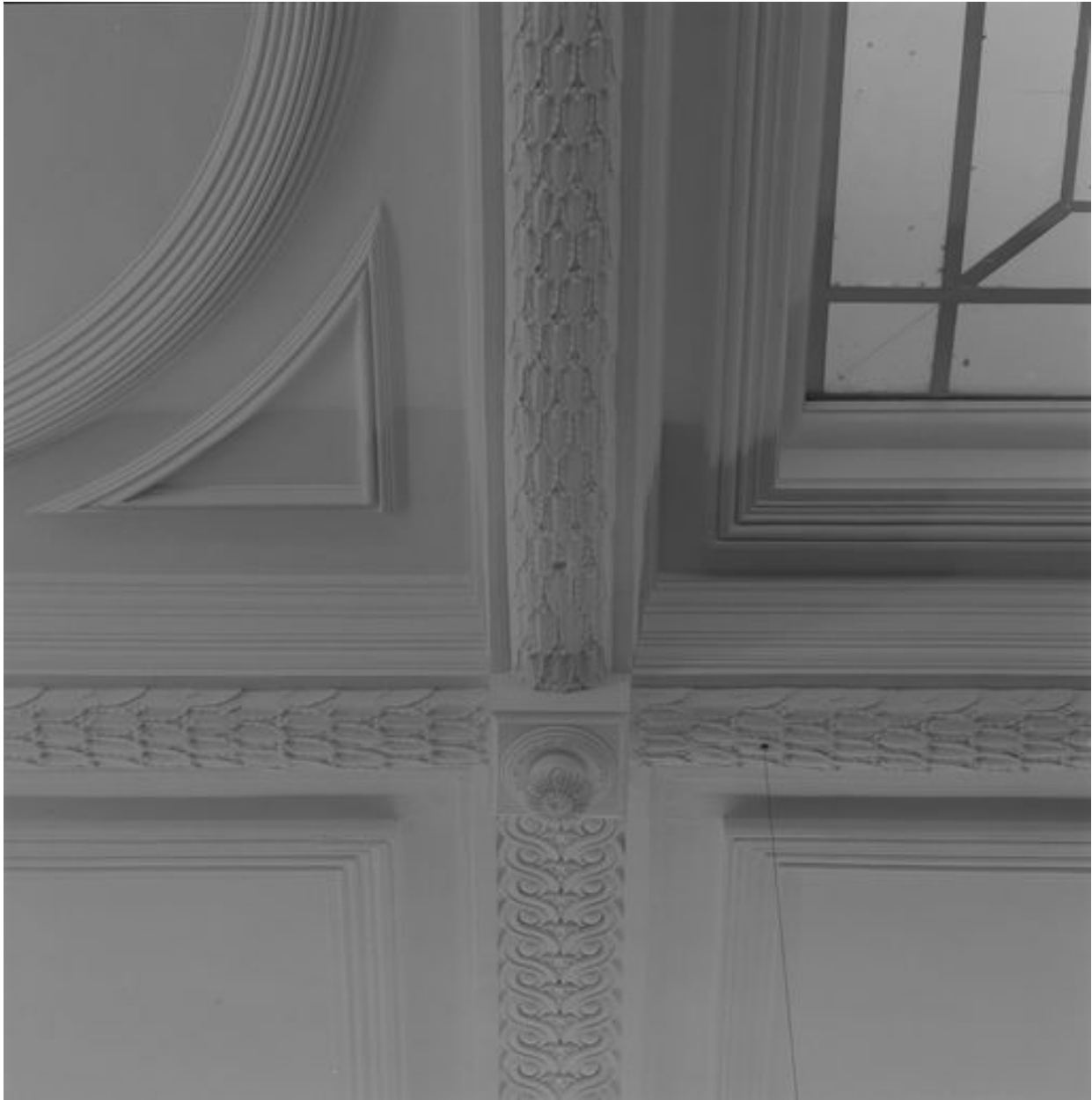
Vue intérieure : salle d'audience de la cour d'appel, détail des moulures du plafond à caissons.
