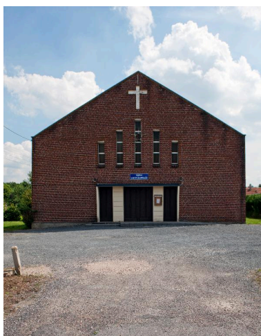
Église paroissiale Saint-Raphaël d'Aulnoye-Aymeries. Phot. Pierre Thibaut IVR31_20145903242NUCA
