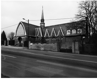
Couvent des Dominicains de Ferrière-la-Grande. Phot. Thierry Petitberghien IVR31_20025900373X
