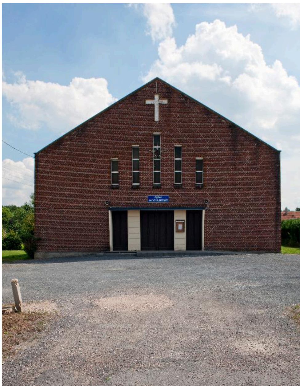
Église paroissiale Saint-Raphaël d'Aulnoye-Aymeries.
