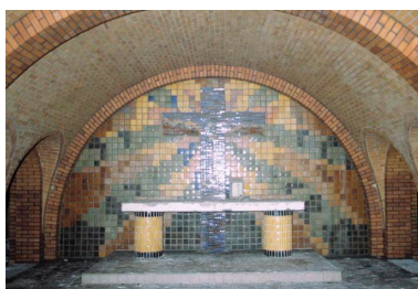
Vue du chœur de la crypte de la chapelle Notre-Dame de Lourdes à Louvroil. Phot. Thierry Petitberghien IVR31_20025901778ZA
