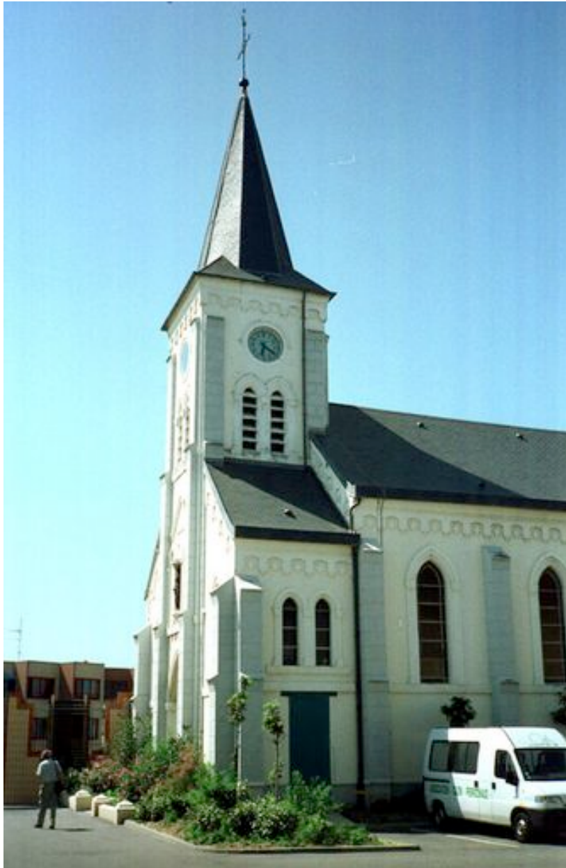
Vue générale de trois quarts de la chapelle en 1996.
