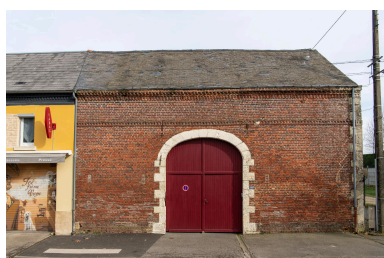
Grange, n°160 rue des Acacias, vue depuis le sud-ouest. Phot. Marc Kérignard IVR32_20236000103NUCA
