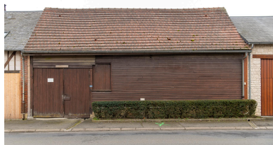
Grange sur rue, n°451 rue des Acacias, vue depuis le nord-est. Phot. Marc Kérignard IVR32_20236000126NUCA
