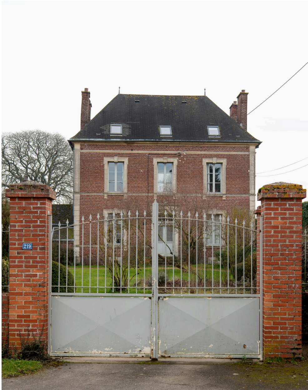
Demeure de notable, n°219 rue des Marronniers, vue depuis le nord.
