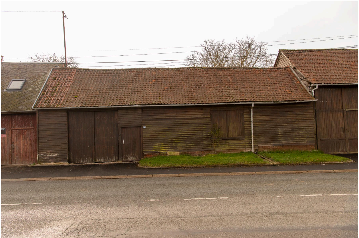
Grange sur rue avec entrée charretière, n°292 rue des Bouleaux, vue depuis le nord.
