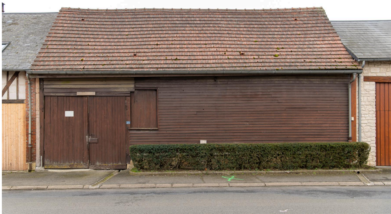
Grange sur rue, n°451 rue des Acacias, vue depuis le nord-est.
