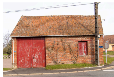
Grange sur rue avec entrée charretière, n°313 rue des Bouleaux, vue depuis le sud. Phot. Marc Kérignard IVR32_20236000108NUCA
