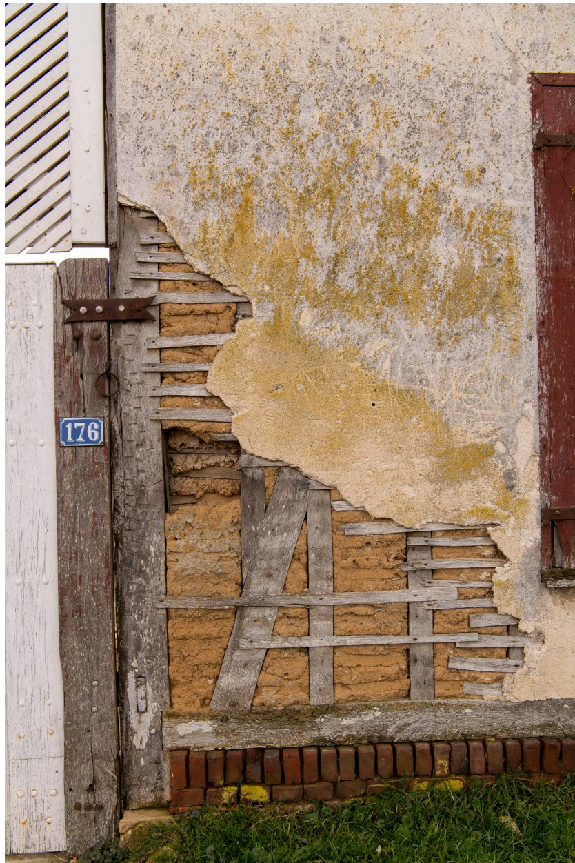
Détail de maçonnerie en torchis et pan de bois, n°176 rue des Bouleaux, vue prise depuis le nord.
