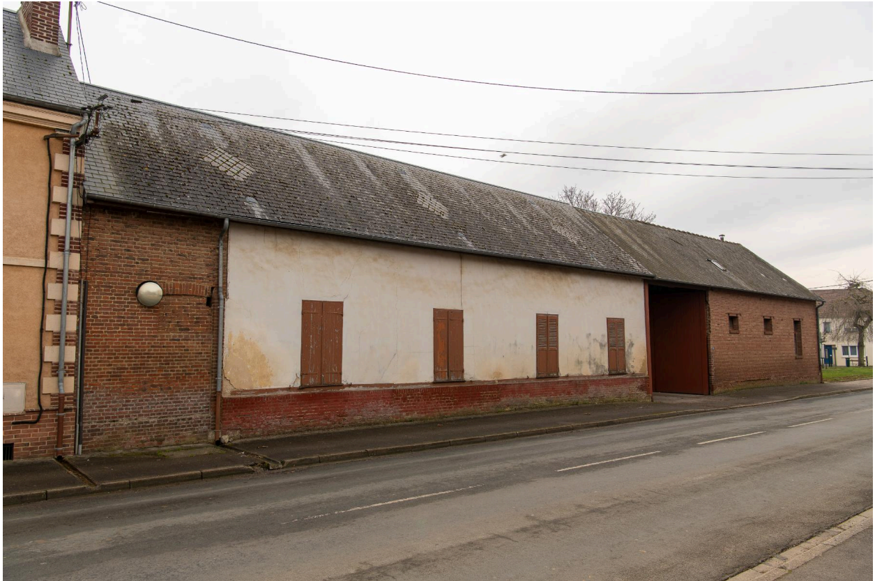
Ferme à cour, n°56 rue des Cytises, vue depuis le nord.
