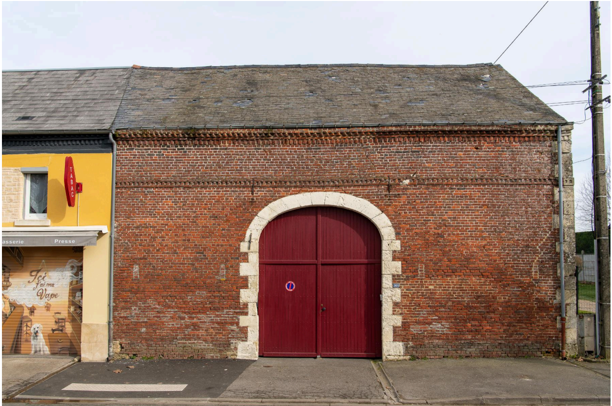
Grange, n°160 rue des Acacias, vue depuis le sud-ouest.
