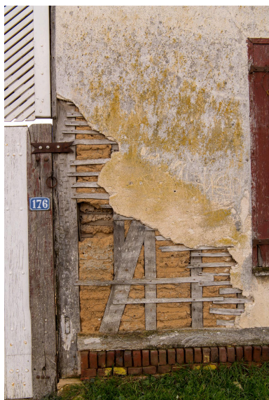
Détail de maçonnerie en torchis et pan de bois, n°176 rue des Bouleaux, vue prise depuis le nord. Phot. Marc Kérignard IVR32_20236000106NUCA
