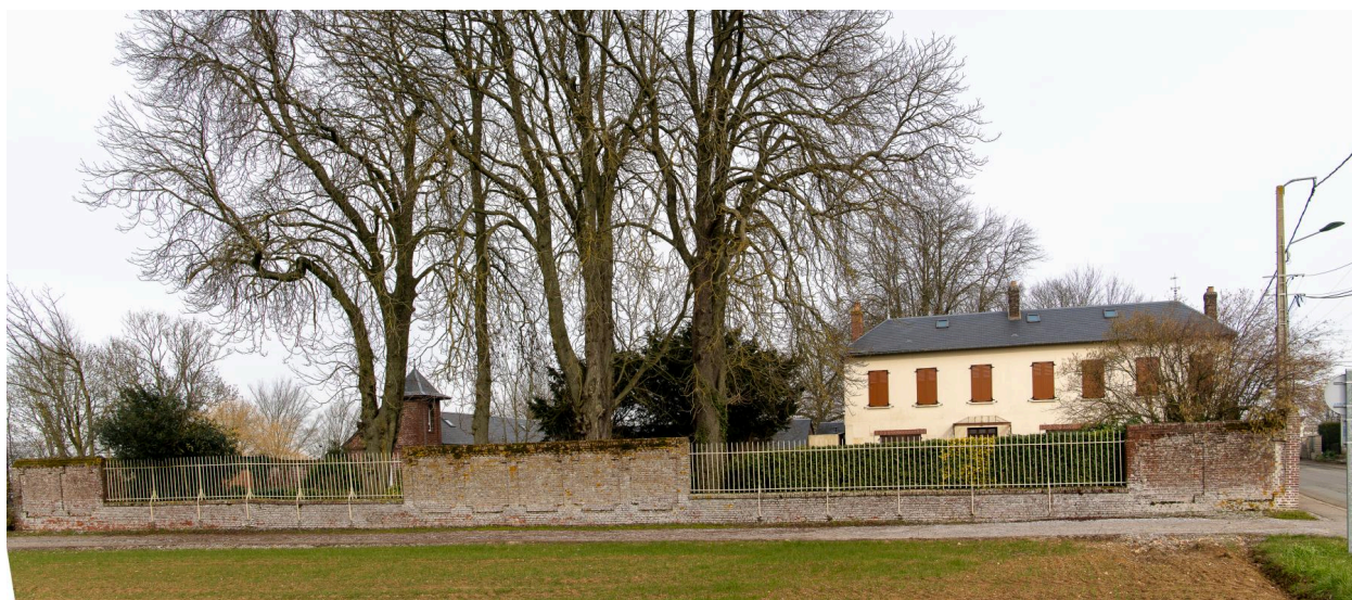
Demeure de la famille Tribout dite "Le Château", n°443 rue des Cytises, vue depuis le sud-ouest.
