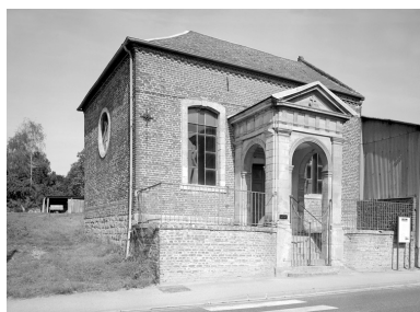
Vue de trois-quarts, depuis le sud. Phot. Irwin Leullier IVR22_19978000818X
