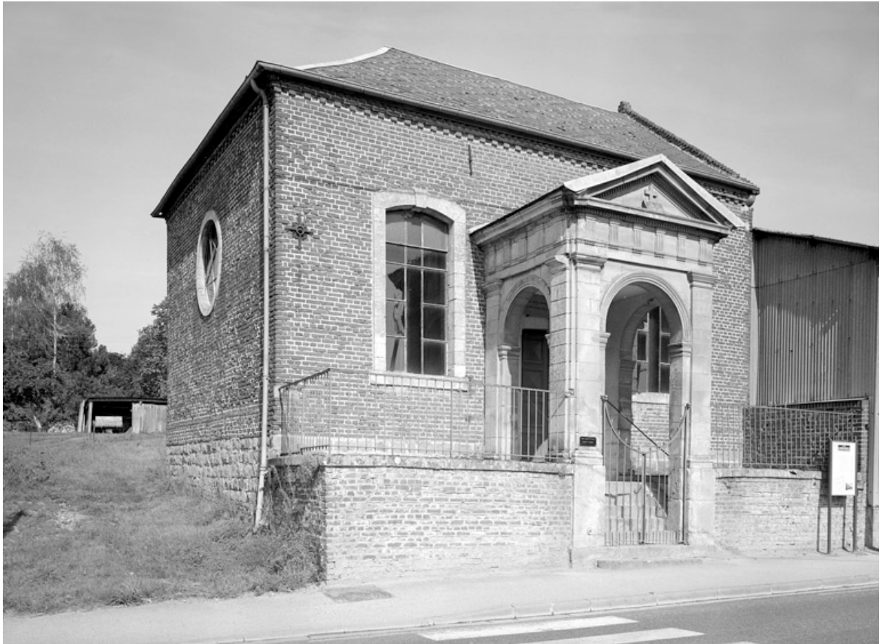
Vue de trois-quarts, depuis le sud.
