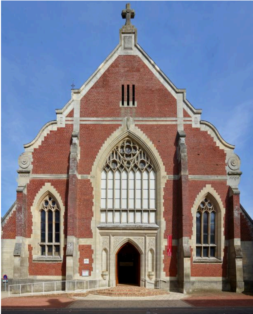
Vue générale de la façade de l'église.
