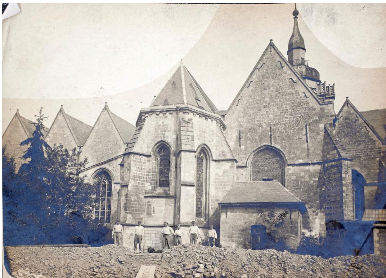
Chantier de construction de l'École primaire supérieure : ouvriers devant les bas-côtés est de l'église Saint-Nicolas. (AD Pas-de-Calais, 20612/2).
