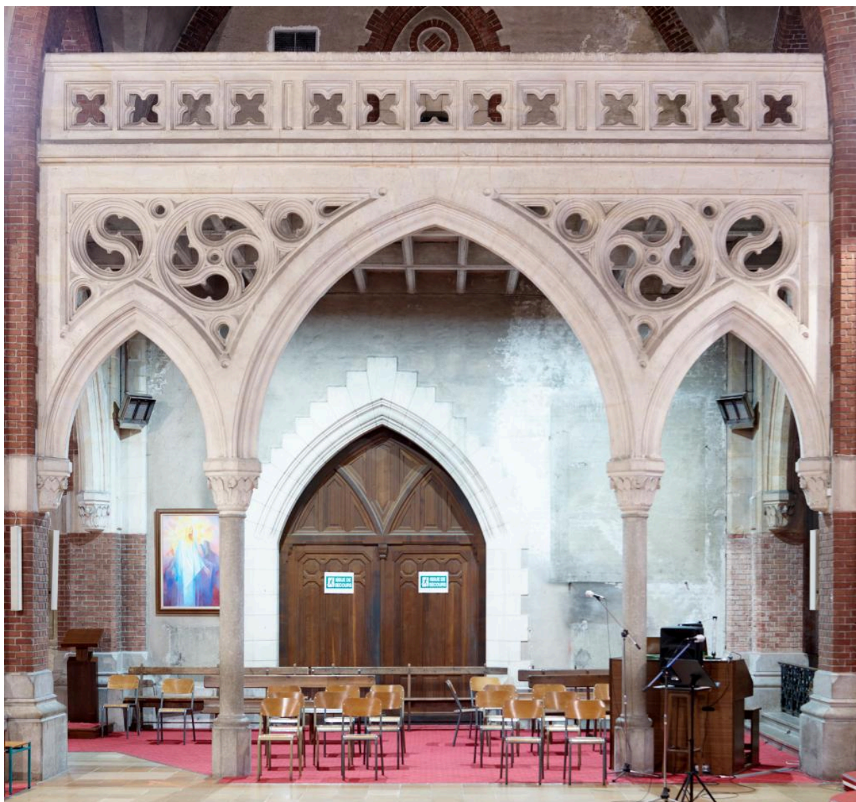
Tribune néogothique. Vue depuis la nef de la façade Est.
