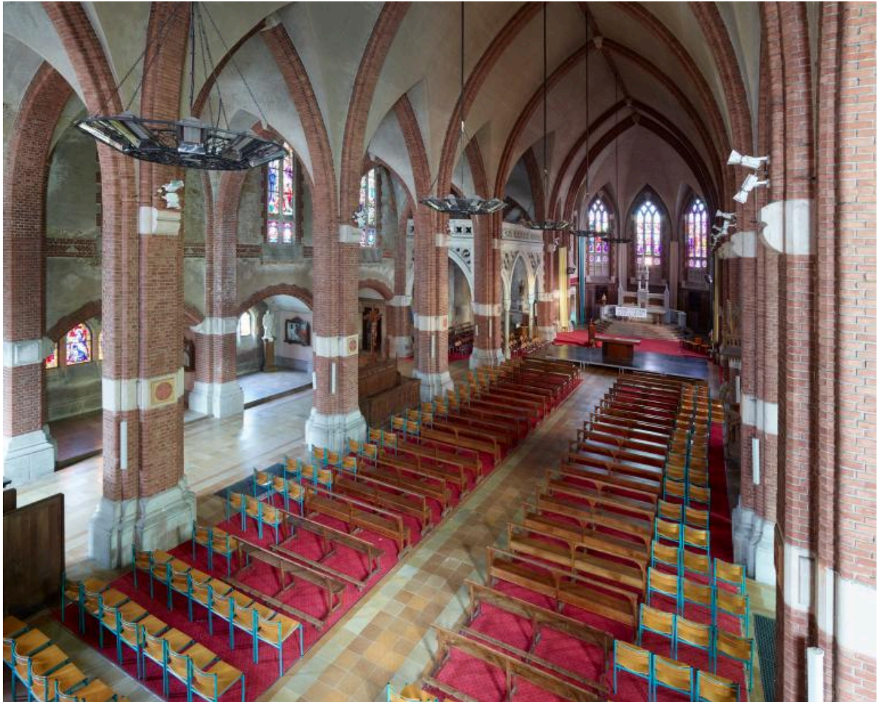
Vue intérieure orientée Nord-sud, vers le chœur depuis la tribune.
