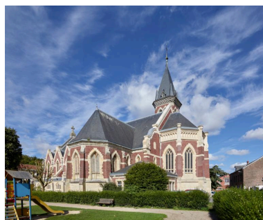
Vue générale extérieure de l'église : côté sud et chevet depuis le jardin des mères. Phot. Hubert Bouvet IVR32_20196200372NUC4A
