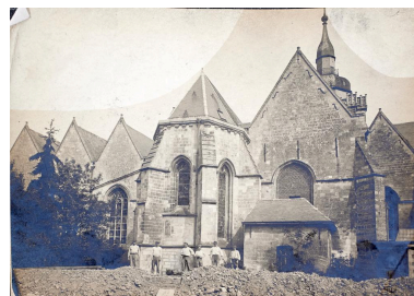
Chantier de construction de l'École primaire supérieure : ouvriers devant les bas-côtés est de l'église Saint-Nicolas. (AD Pas-de-Calais, 20612/2). Phot. Thibaut Pierre (reproduction) IVR32_20216200243NUCA
