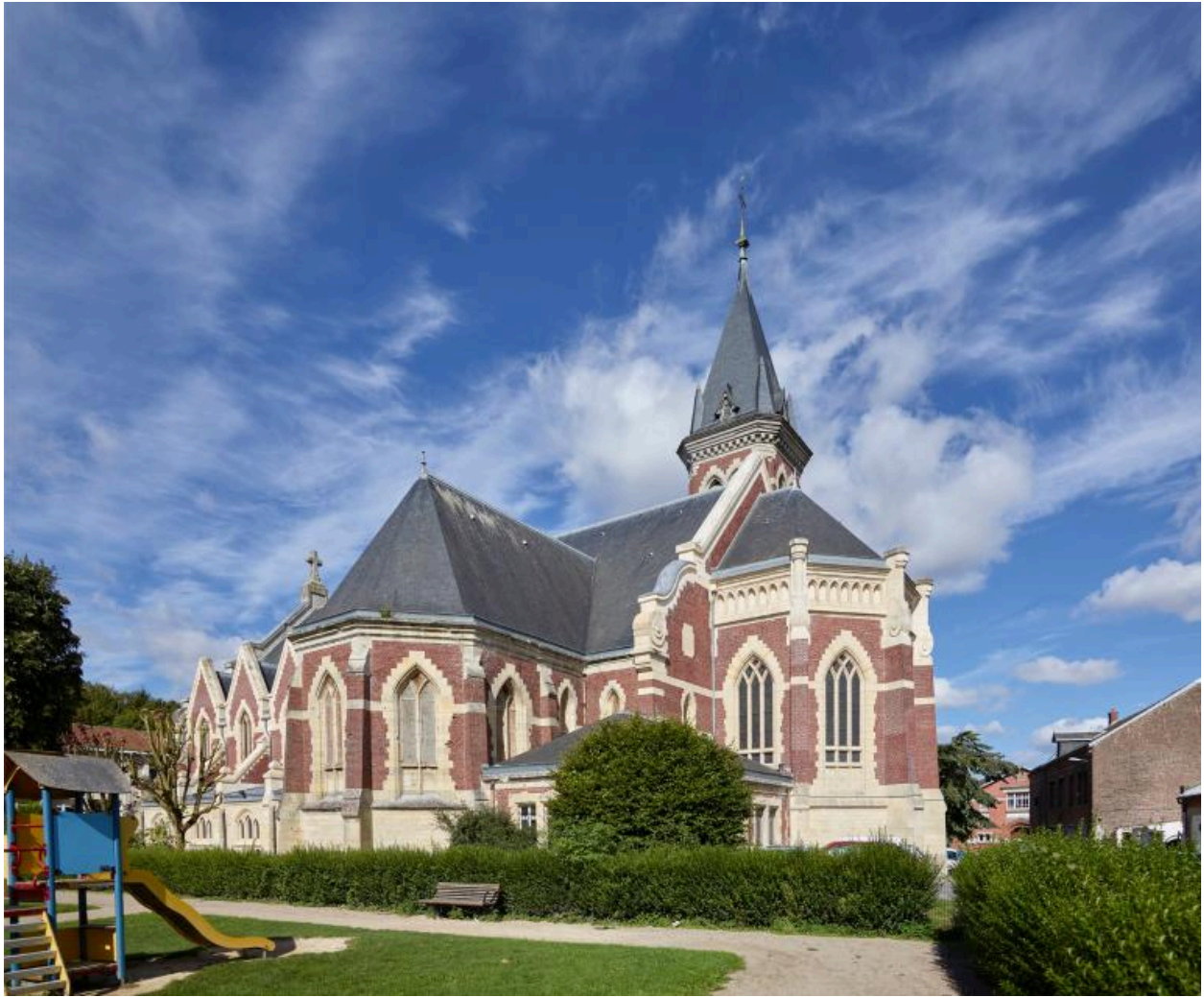
Vue générale extérieure de l'église : côté sud et chevet depuis le jardin des mères.
