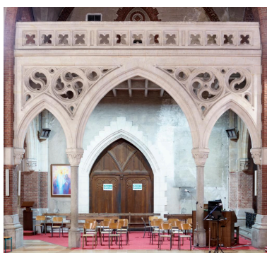
Tribune néogothique. Vue depuis la nef de la façade Est. Phot. Delphine Volto-Jourdan IVR32_20216200561NUCA
