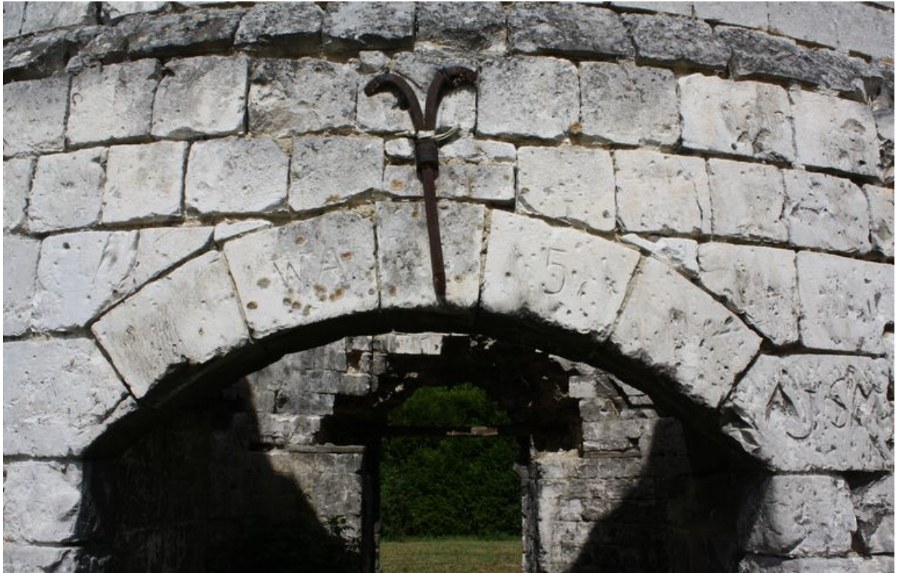
Flixecourt, moulin Basile : détail du linteau de la porte.
