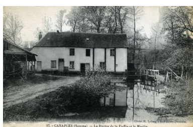
Canaples, ancien moulin à huile (coll. part.). Phot. Monnehay-Vulliet Marie-Laure IVR22_20098000371NUCA
