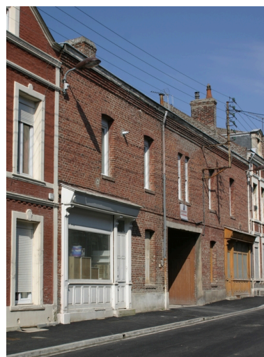
Le petit immeuble à boutiques donnant accès à la cité ouvrière construite vers 1925. Phot. Frédéric Pillet IVR22_20070205135NUCA
