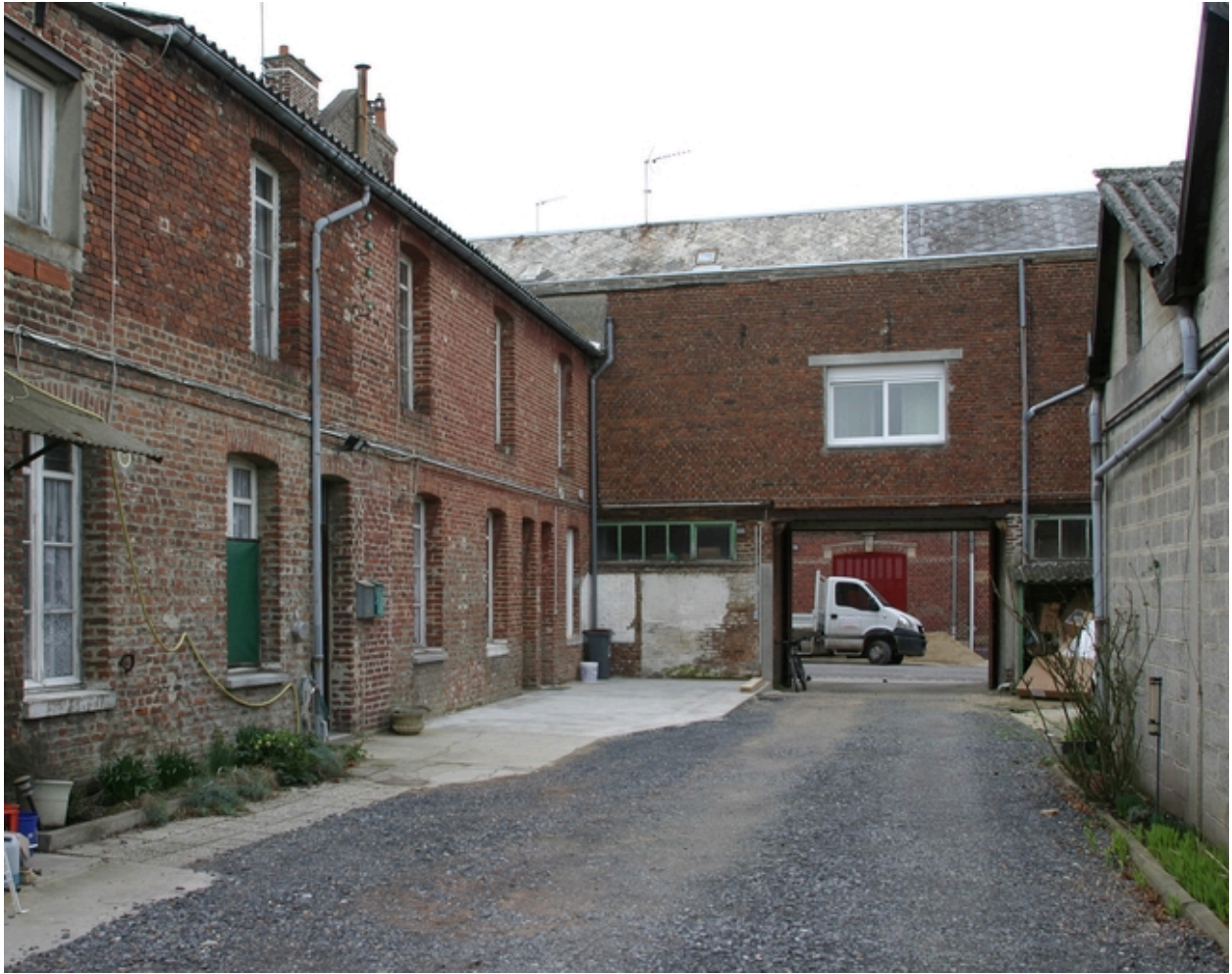
Cour et logements ouvriers construits après 1918.
