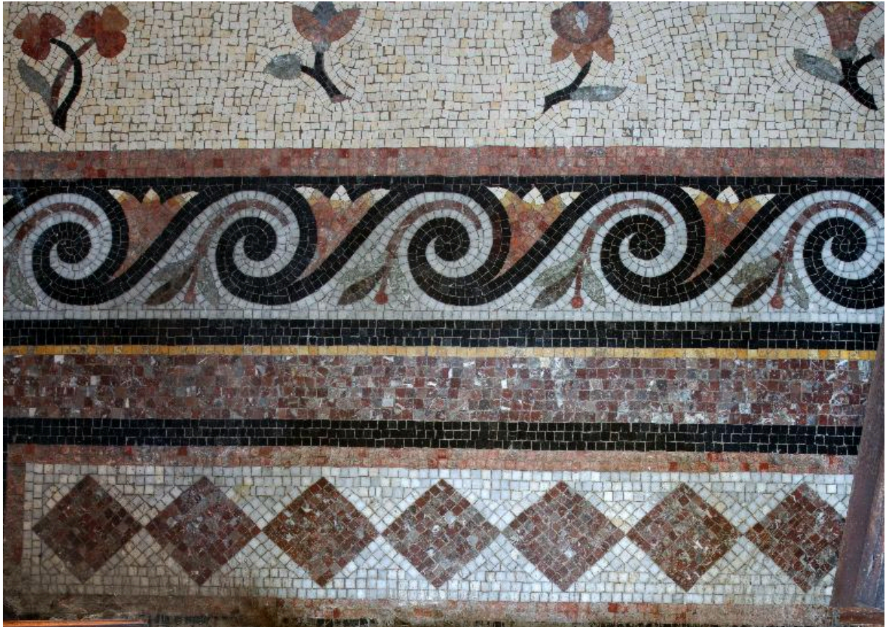
Pavage du vestibule, détail de la frise.
