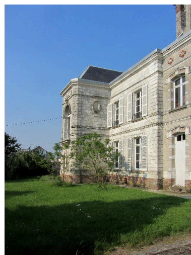
Façade postérieure, détail de l'avant corps central, vue de trois-quarts. Phot. Fournier Bertrand (reproduction) IVR22_20138015738NUC2A
