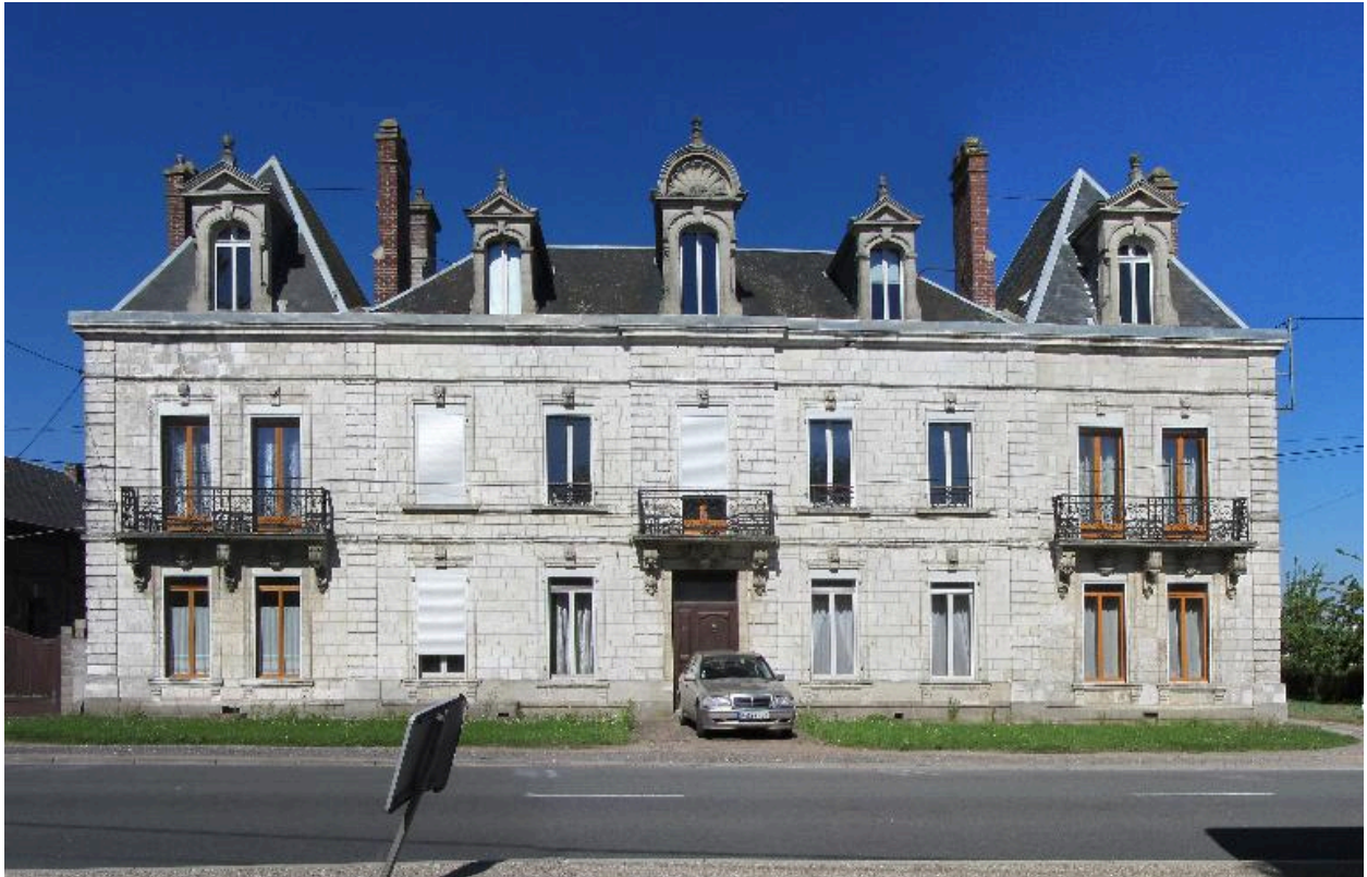
Façade sur rue, vue de face.
