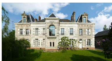
Façade postérieure, vue d'ensemble. Phot. Thierry Lefébure IVR22_20138000214NUC2AQ
