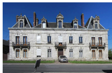
Façade sur rue, vue de face. Phot. Bertrand Fournier IVR22_20138015660NUC2A
