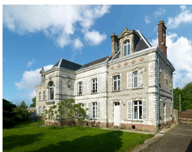
Façade postérieure, vue de trois-quarts. Phot. Thierry Lefébure IVR22_20138000213NUC2AQ
