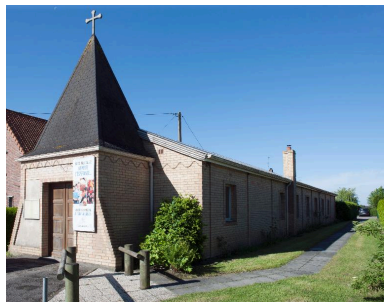
Vue générale. Phot. Pierre Thibaut IVR31_20145902812NUCA
