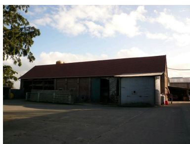
Vue de la grange au sud. Phot. Inès Guérin IVR22_20058006384NUCA
