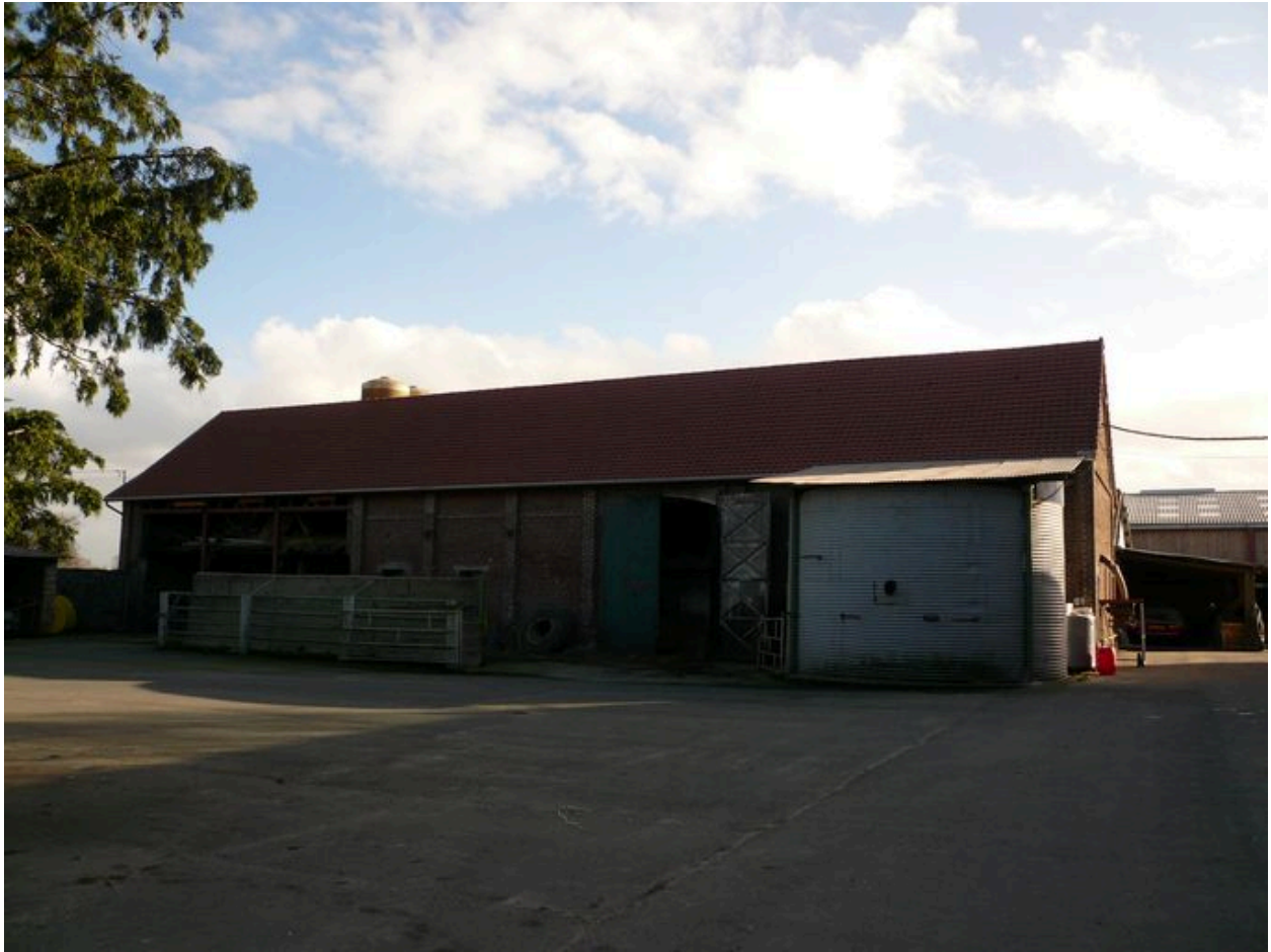
Vue de la grange au sud.
