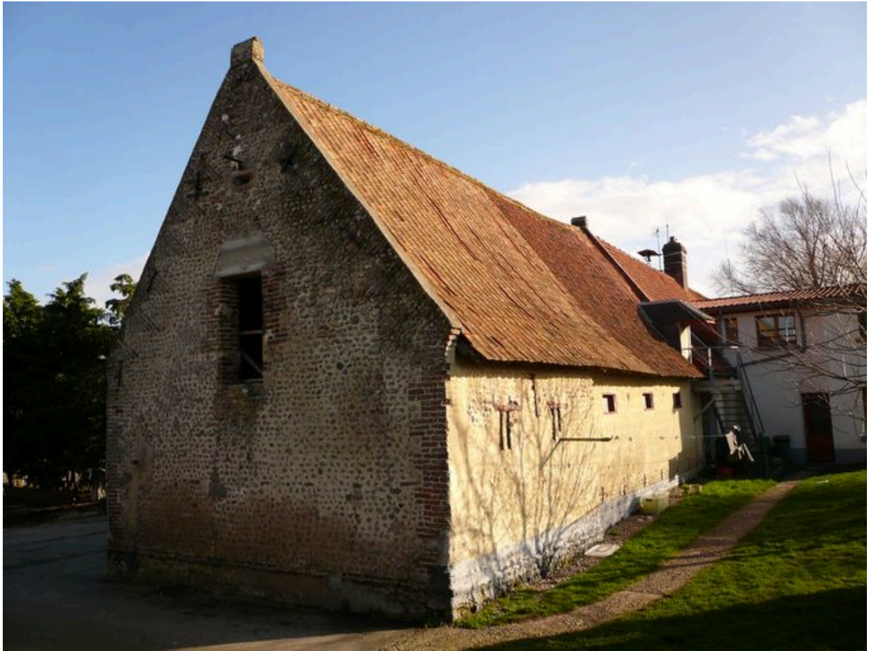
Vue postérieure de l'écurie.
