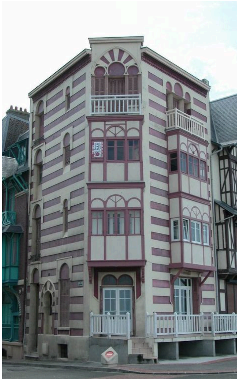
Vue d'ensemble depuis l'esplanade.
