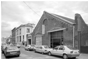
Vue générale. Phot. Benoît Dufournier IVR22_19918000236Z
