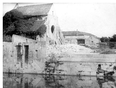
La collégiale depuis le petit bras de l'Oise en cours de démolition (AC Creil). Phot. Clarisse Lorieux IVR22_20076005133NUCAB
