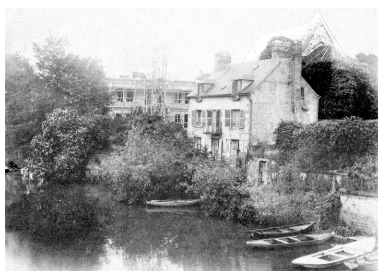
L'île Saint-Maurice : l'hôtel de ville en construction et la collégiale à droite envahie par la végétation (AC Creil). Phot. Clarisse Lorieux IVR22_20076005136NUCAB
