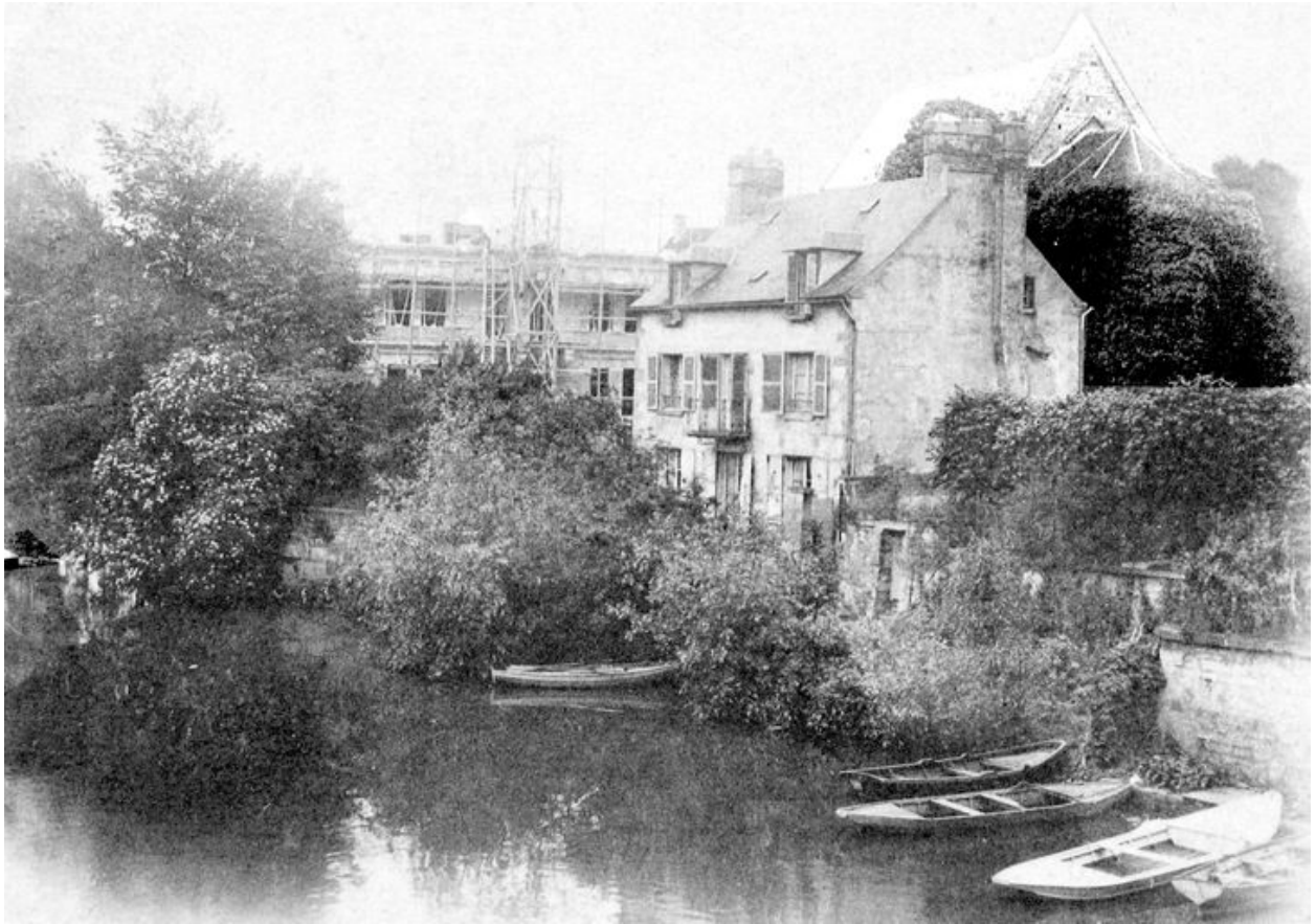
L'île Saint-Maurice : l'hôtel de ville en construction et la collégiale à droite envahie par la végétation (AC Creil).
