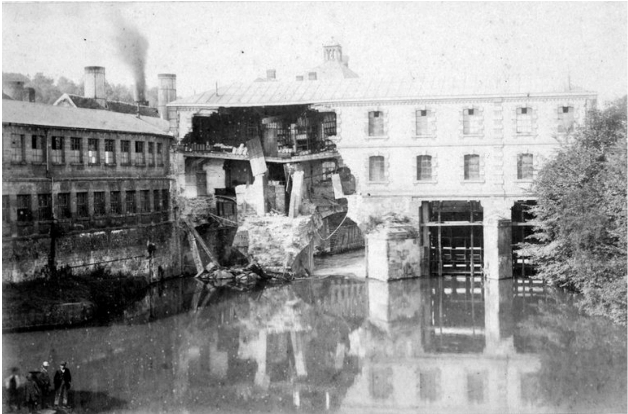
Effondrement d'une partie des bâtiments construits sur le petit bras de l'Oise, vers 1890 (musée Gallé-Juillet, Creil).
