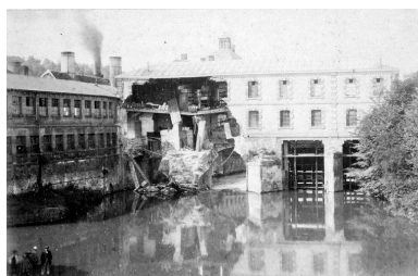
Effondrement d'une partie des bâtiments construits sur le petit bras de l'Oise, vers 1890 (musée Gallé-Juillet, Creil). Phot. Clarisse Lorieux IVR22_20076005436NUCAB
