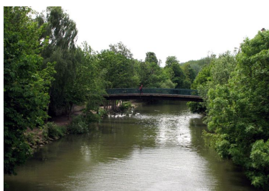
Passerelle construite sur le petit bras de l'Oise à l'emplacement du moulin. Phot. Clarisse Lorieux IVR22_20076005283NUCA
