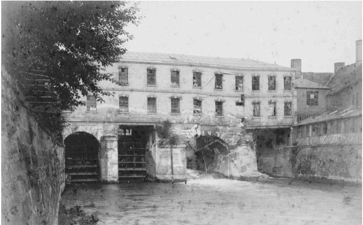
Vue du bâtiment construit sur le petit bras de l'Oise en aval. On distingue à droite les deux roues hydrauliques verticales sous les arches du pont (musée Gallé-Juillet, Creil).
