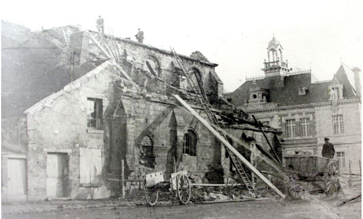
La collégiale en cours de démolition au début du 20e siècle. A l'arrière-plan le nouvel hôtel de ville (AC Creil).
