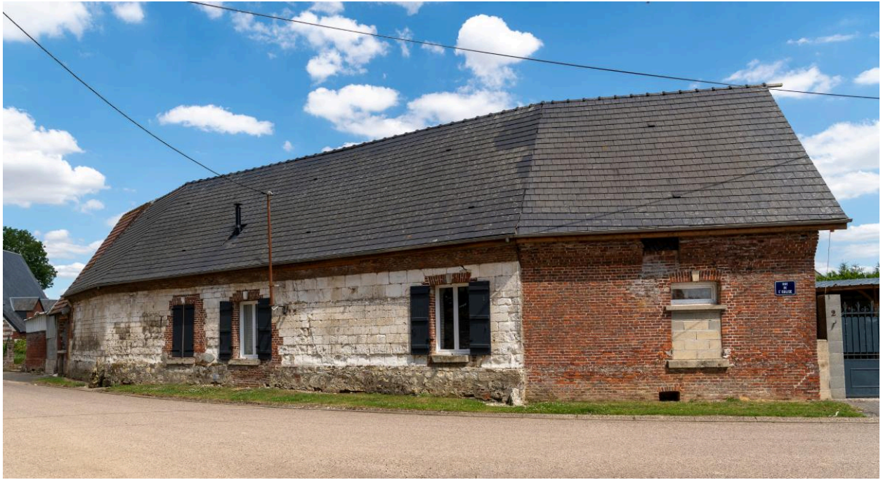
Maison en pierre (fin 18e ou début 19e siècle ?), n°2-4 rue de l'Église.
