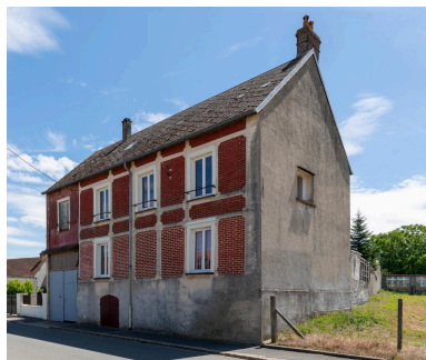
Ancien commerce ?, n°14 rue Neuve, vue depuis le nord-ouest. Phot. Marc Kérignard IVR32_20226000697NUCA
