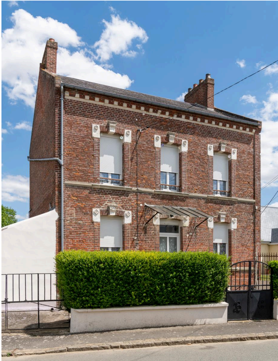
Demeure de l'ancien patron de la briqueterie (?), n°8 rue des Belles Dames, vue depuis l'ouest.
