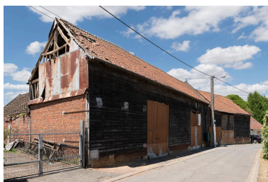
Anciennes granges sur rue, n°9-13 rue Jeannette, vue depuis l'est. Phot. Marc Kérignard IVR32_20226000685NUCA
