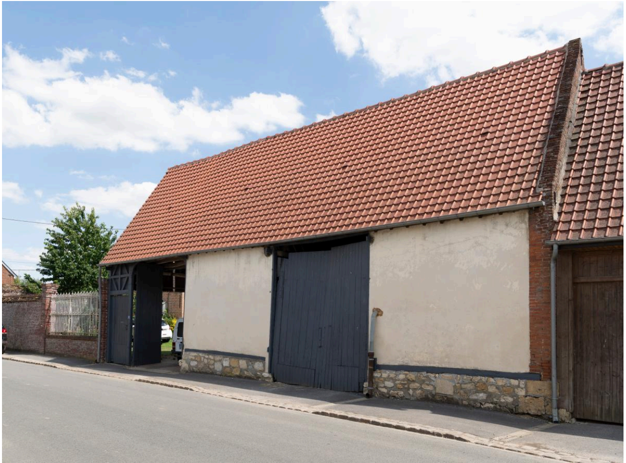
Ancienne grange sur rue, n°6 rue Neuve, vue depuis le nord-ouest.
