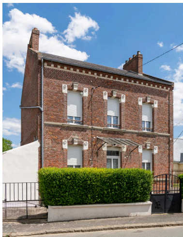
Demeure de l'ancien patron de la briqueterie (?), n°8 rue des Belles Dames, vue depuis l'ouest. Phot. Marc Kérignard IVR32_20226000693NUCA
