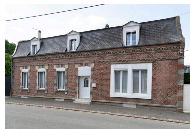
Ancien café de la Gare, n°14 rue de la Gare, vue depuis le sud. Phot. Marc Kérignard
