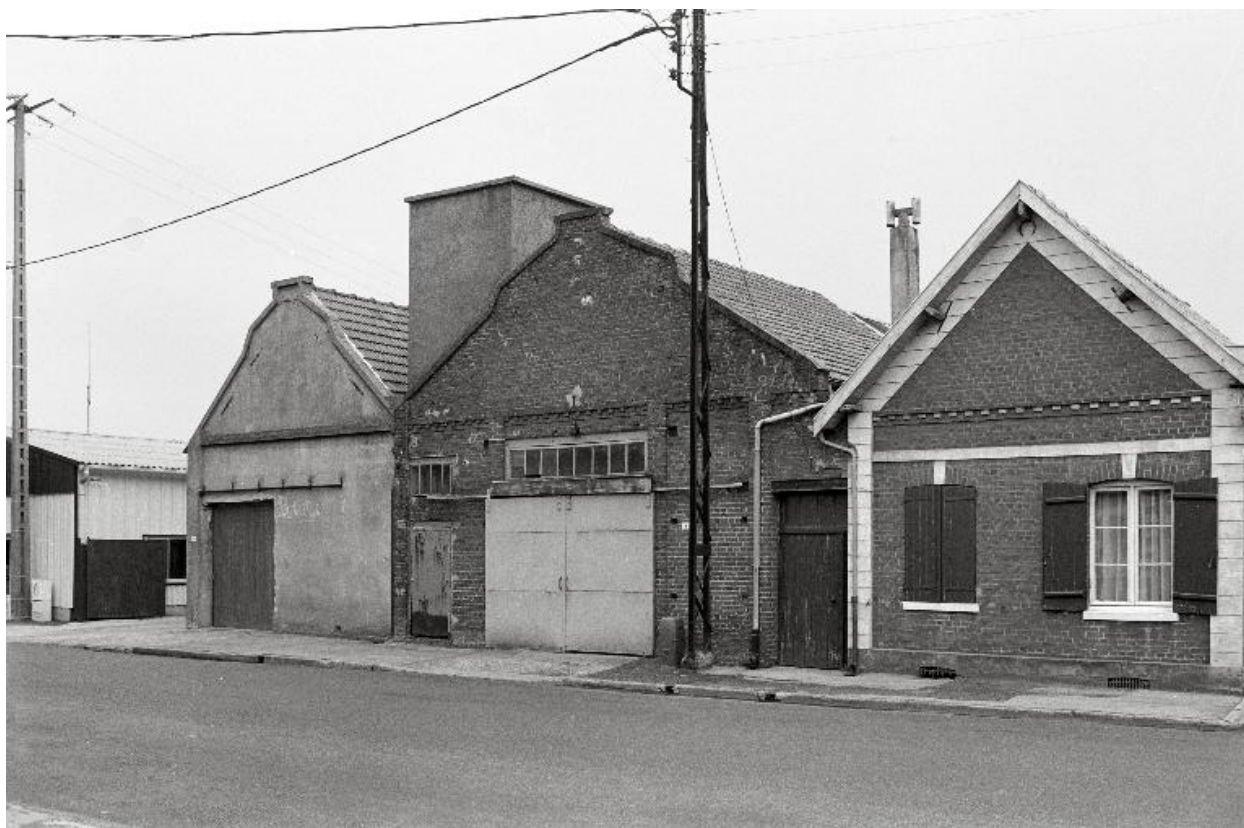
Vue depuis la rue des anciens ateliers de la fonderie Riquier, puis Ouzoux.
