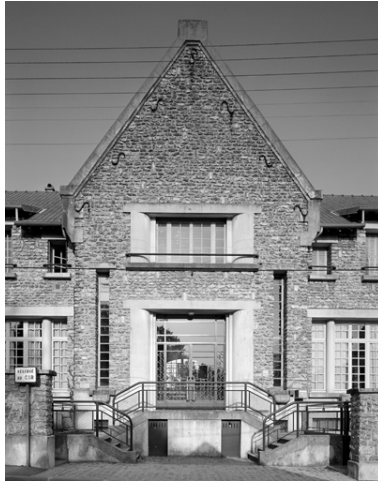
L'avant-corps central. Phot. Thierry Lefébure IVR22_19940201186V
