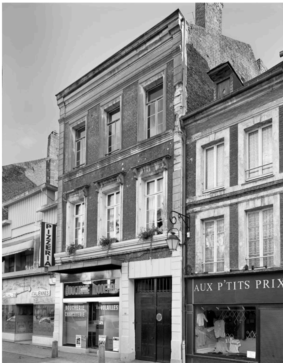
Vue de la façade sur rue.
