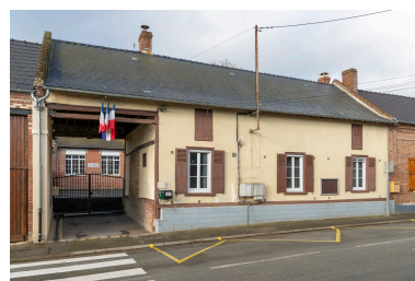
Ancienne école aujourd'hui mairie, n°6 de la rue Marcel Dassault, vue depuis l'est. Phot. Marc Kérignard IVR32_20236001156NUCA
