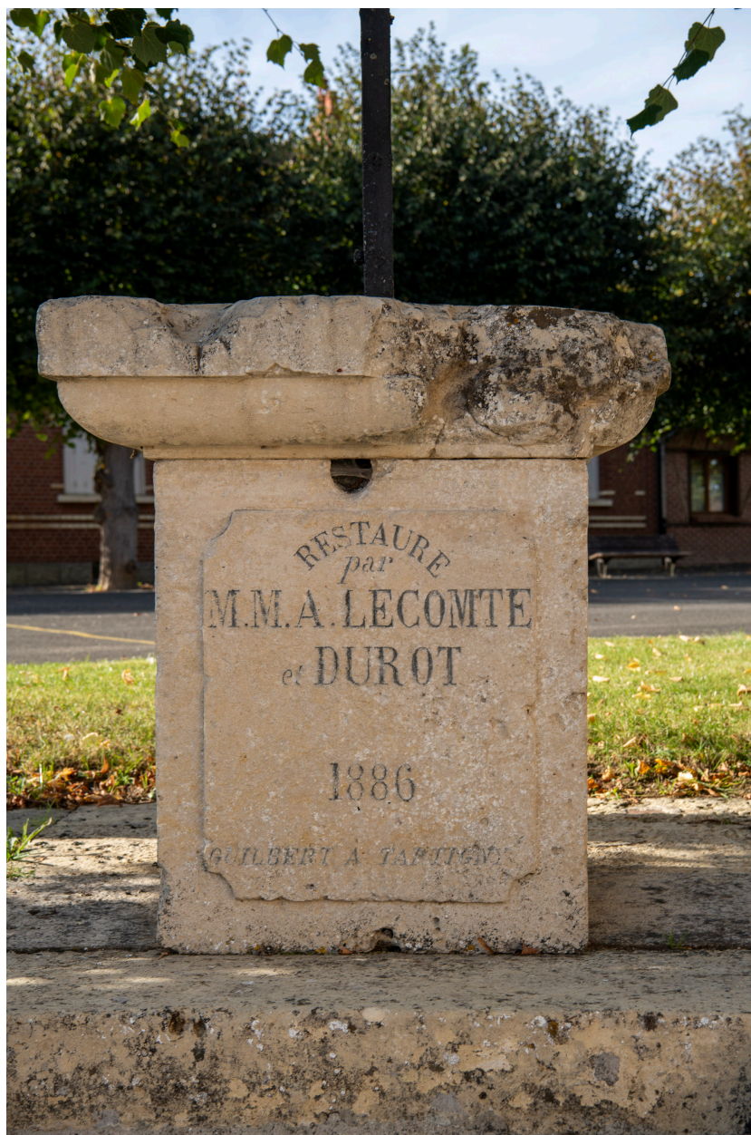
Socle de la croix restaurée par Lecomte-Durot en 1886, place publique, vue depuis le sud.
