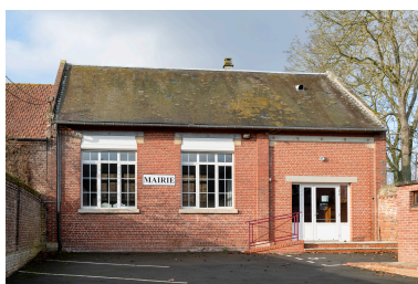
Ancienne école, aujourd'hui mairie, n°6 de la rue Marcel Dassault, vue depuis l'est. Phot. Marc Kérignard IVR32_20236001155NUCA
