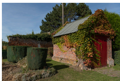
Remise des pompes à incendie, place de l'église. Phot. Marc Kérignard IVR32_20236001121NUCA
