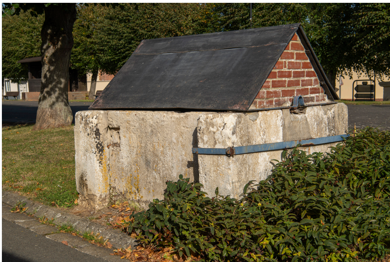
Ancien puits, place publique, vue depuis l'ouest.
