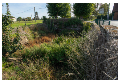
Ancienne mare, rue de la Ploye, vue depuis le nord. Phot. Marc Kérignard IVR32_20236001134NUCA
