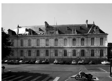
Vue de la façade nord. Phot. Thierry Lefébure IVR22_20038000762PA
