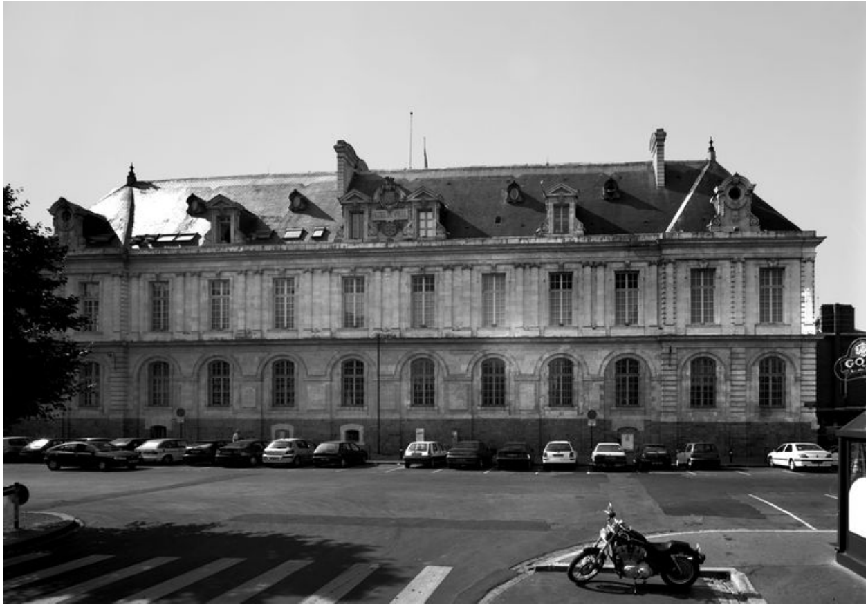
Vue de la façade nord.
