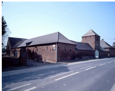
Vue générale. Phot. Pierre Thibaut IVR31_20095902062VA
