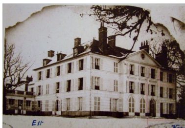
Vue ancienne du château (AD Aisne : 15 R 1773). Phot. Inès Guérin IVR22_20030202661NUCAB
