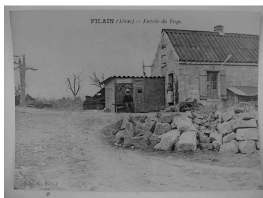
Vue de l'entrée du village pendant la reconstruction (coll. part). Phot. Inès Guérin IVR22_20030203088NUCAB
