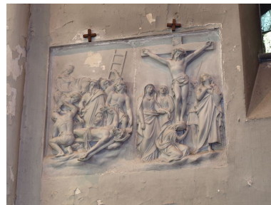
Vue partielle Phot. Julien Marasi IVR31_20126201537NUCA
