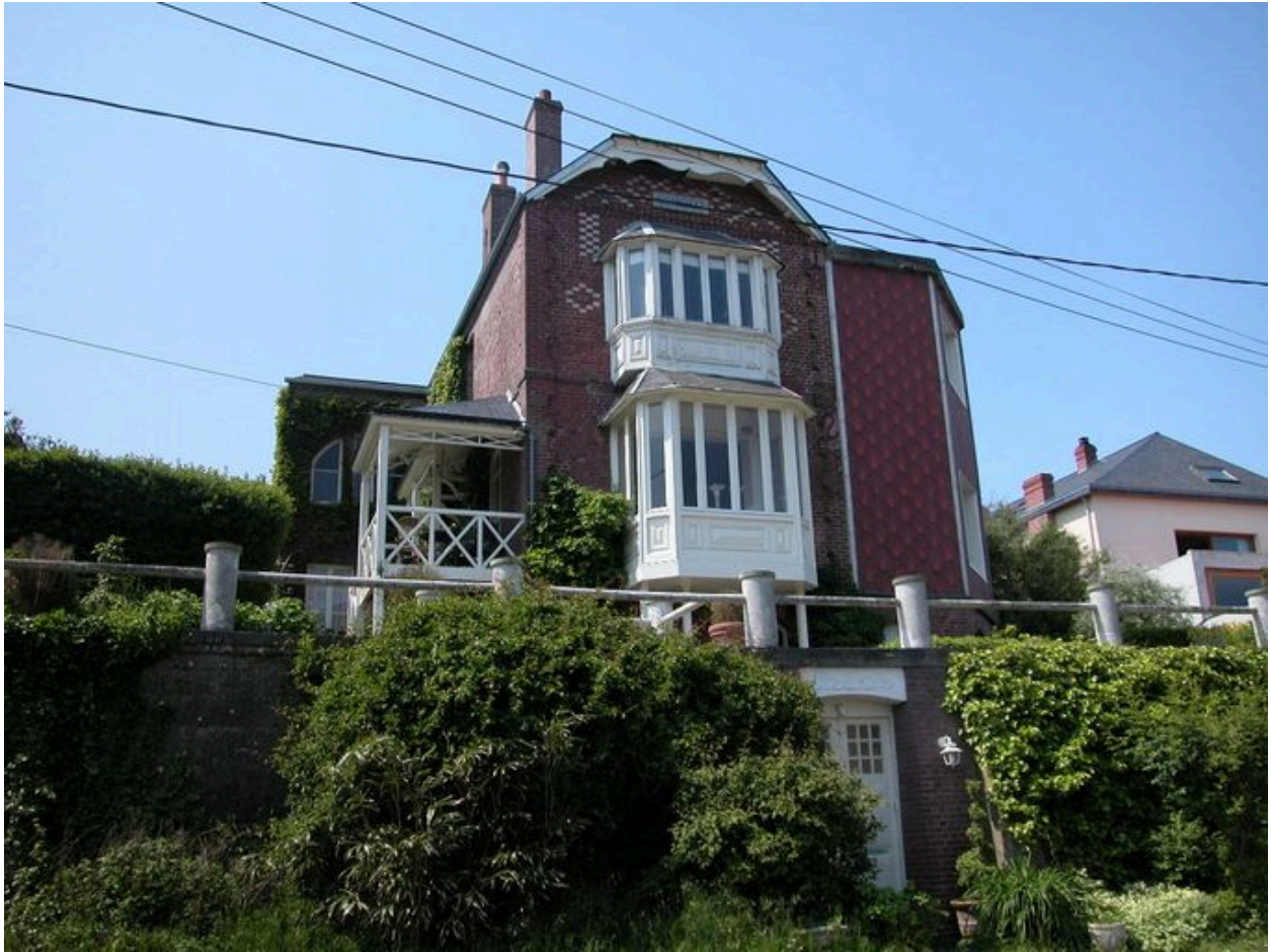
Vue d'ensemble, élévation côté mer.
