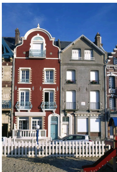
Vue d'ensemble depuis l'esplanade. Phot. Marie-Laure Monnehay-Vulliet IVR22_20048000296XA
