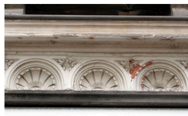
Détail de la frise ornant le linteau de la maison dite Espana. Phot. Elisabeth Justome IVR22_20048001410NUCA
