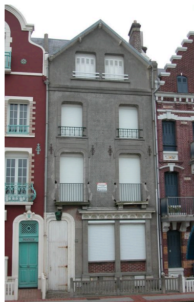
Vue d'ensemble de la maison dite Espana. Phot. Elisabeth Justome IVR22_20048001406NUCA
