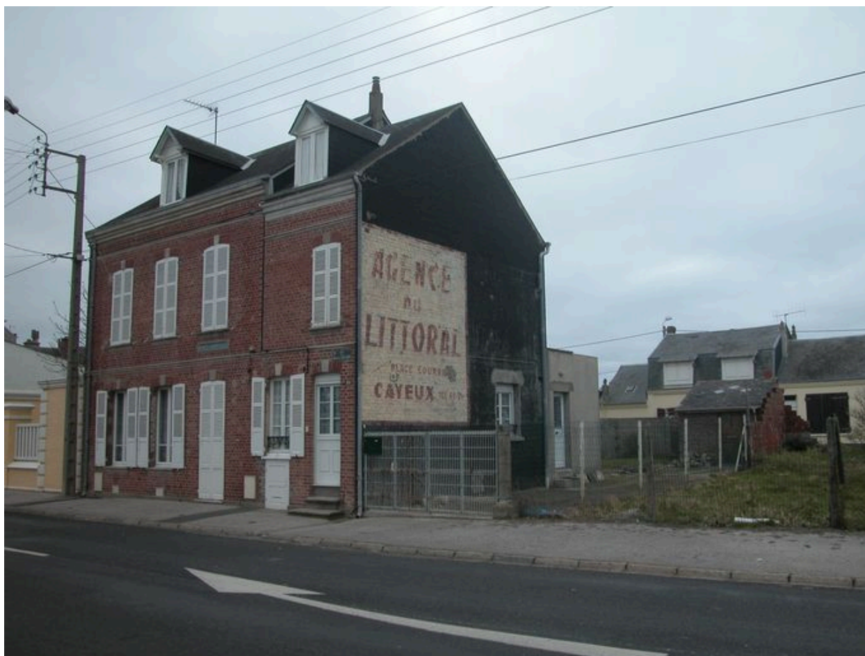
Vue d'ensemble et de trois-quarts, avec annexe en fond de parcelle.
