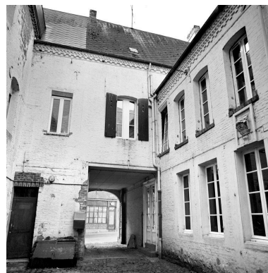
Vue des façades du corps de logis principal et de l'aile gauche sur cour. Phot. Thierry Lefébure IVR22_20020200852X
