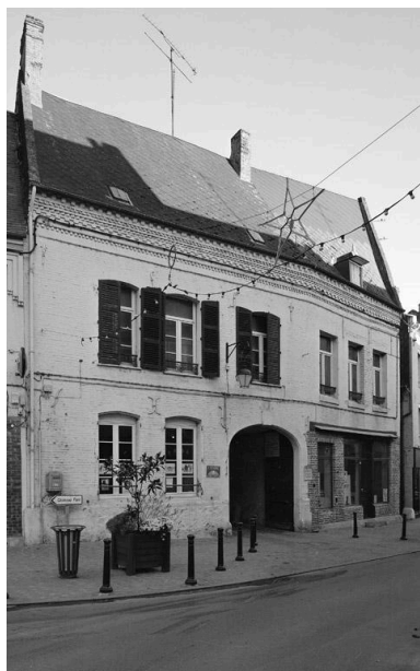
Vue de la façade sur rue. Phot. Thierry Lefébure IVR22_20020201111V
